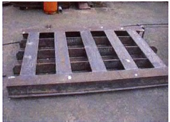
Figura 2.14 Fabricación de compuerta plana deslizante
