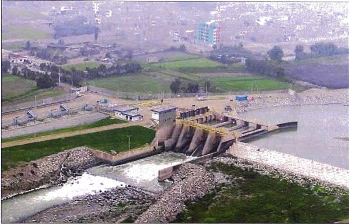
Figura 3.1 Vista panorámica de Bocatoma Huachipa
