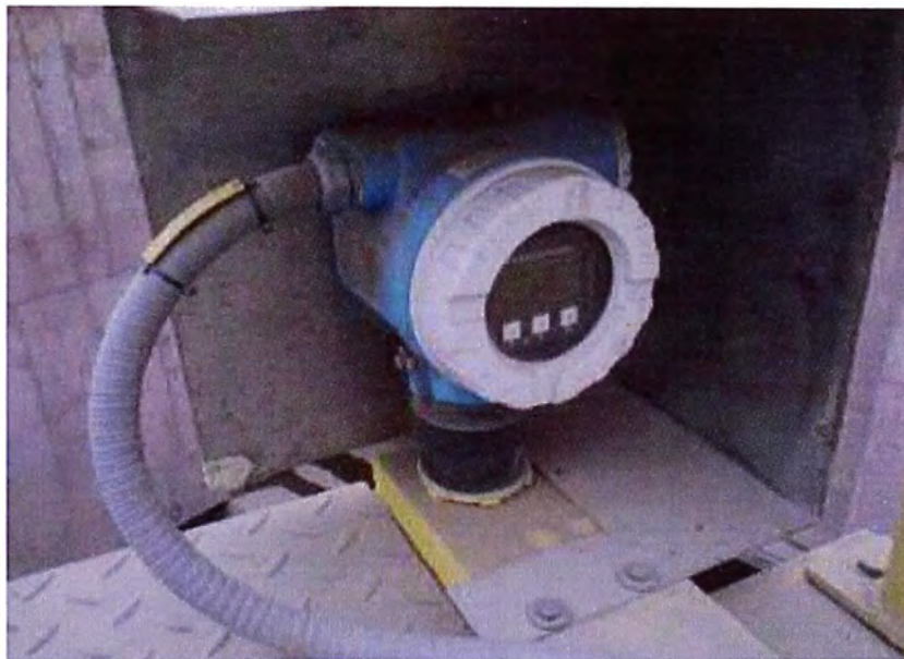
Figura 2.34 Detalle de soporte y protección de sensor de nivel ultrasónico
