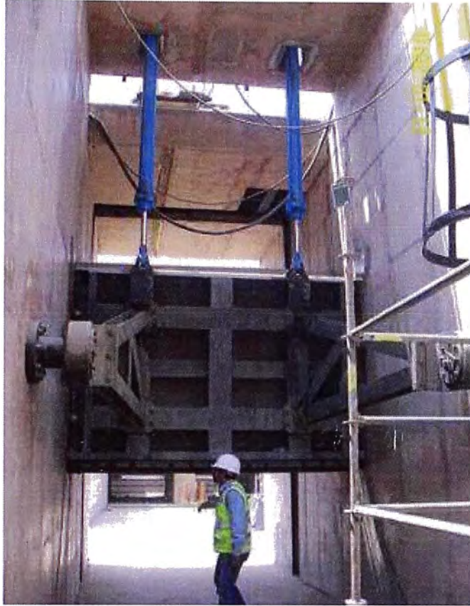
Figura 2.4 Compuerta radial de Captación ensamblada y montada en obra
