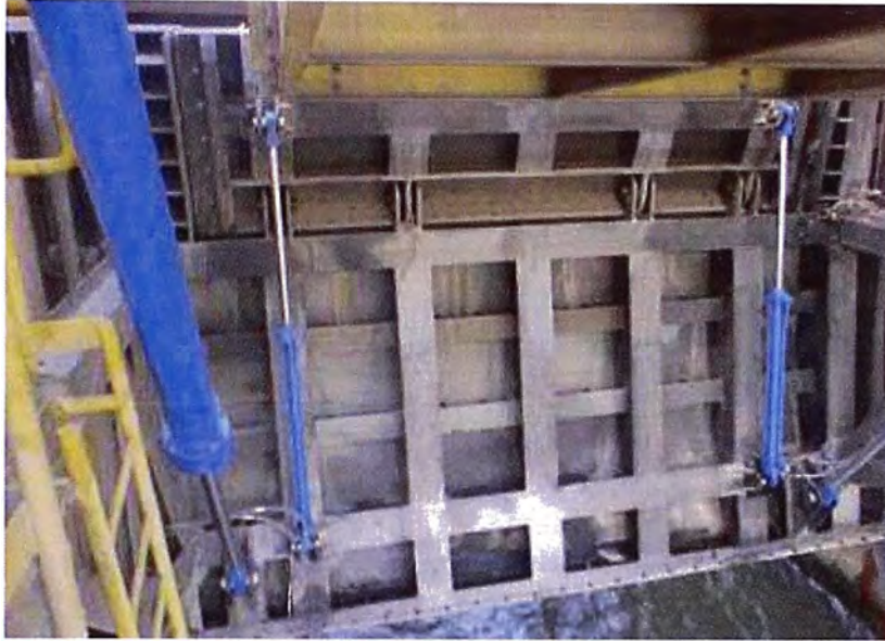
Figura 2.21 Cilindros hidráulicos durante izaje de compuerta radial
