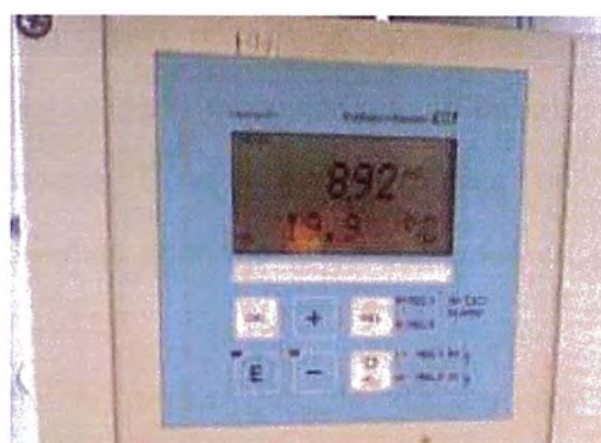
Figura 2.41 Arreglo final de transmisor ORP
