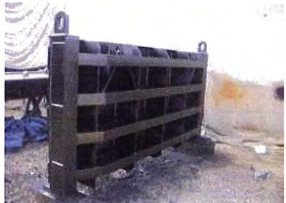
Figura 2.6 Fabricación de ataguía de Captación
