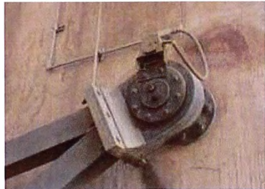
Figura 2.27 Ubicación final de sensor de posición angular en compuerta de Captación
