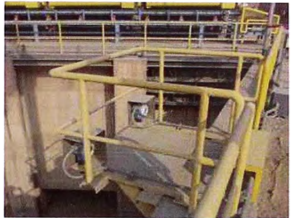
Figura 2.33 Ubicación final de sensor de nivel ultrasónico
