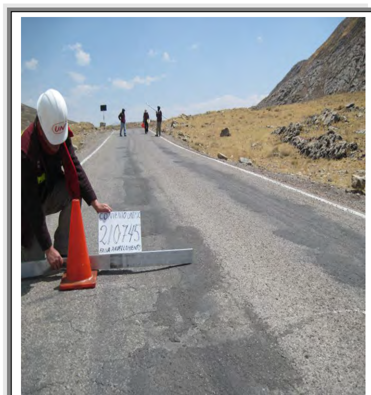
Foto 5.2: Ahuellamiento y Zanjas Reparadas
