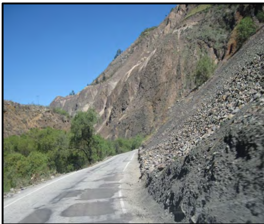
Foto 4.7. Tramo ubicado en la progresiva Km 131+000
