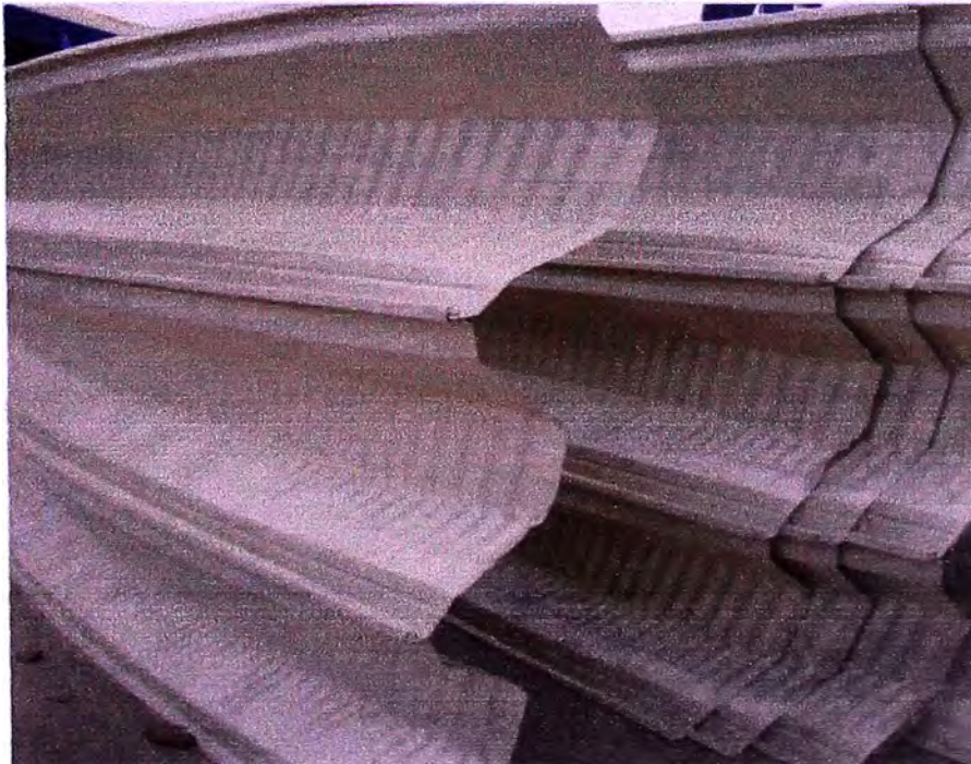
Fig. 5.3 - Foto del perfiles acanalado, curvado y engrampados de a tres listo para su montaje.
