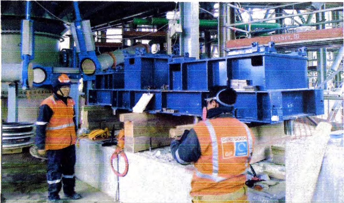
Figura 2.4: Ejemplo de instalación de pedestal para bomba centrífuga, preparación de área previo al montaje de la bomba en planta concentradora Toromocho
