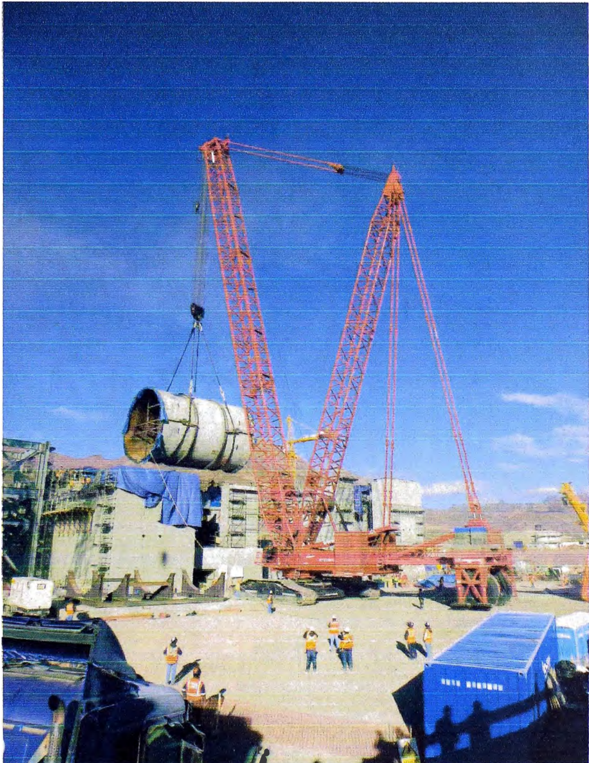
Figura 2.8: Ejemplo de instalación de shell de molino de bolas, montaje desde nivel de terreno a su posición definitiva con grúa de celosía en planta concentradora Toromocho
