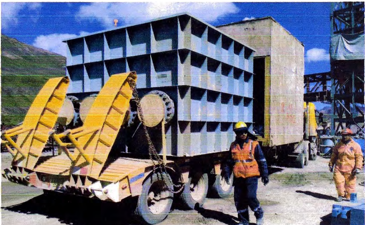
Figura 2.5: Ejemplo de traslado de cajón con camión cama baja a zona de instalación en planta concentradora Toromocho
