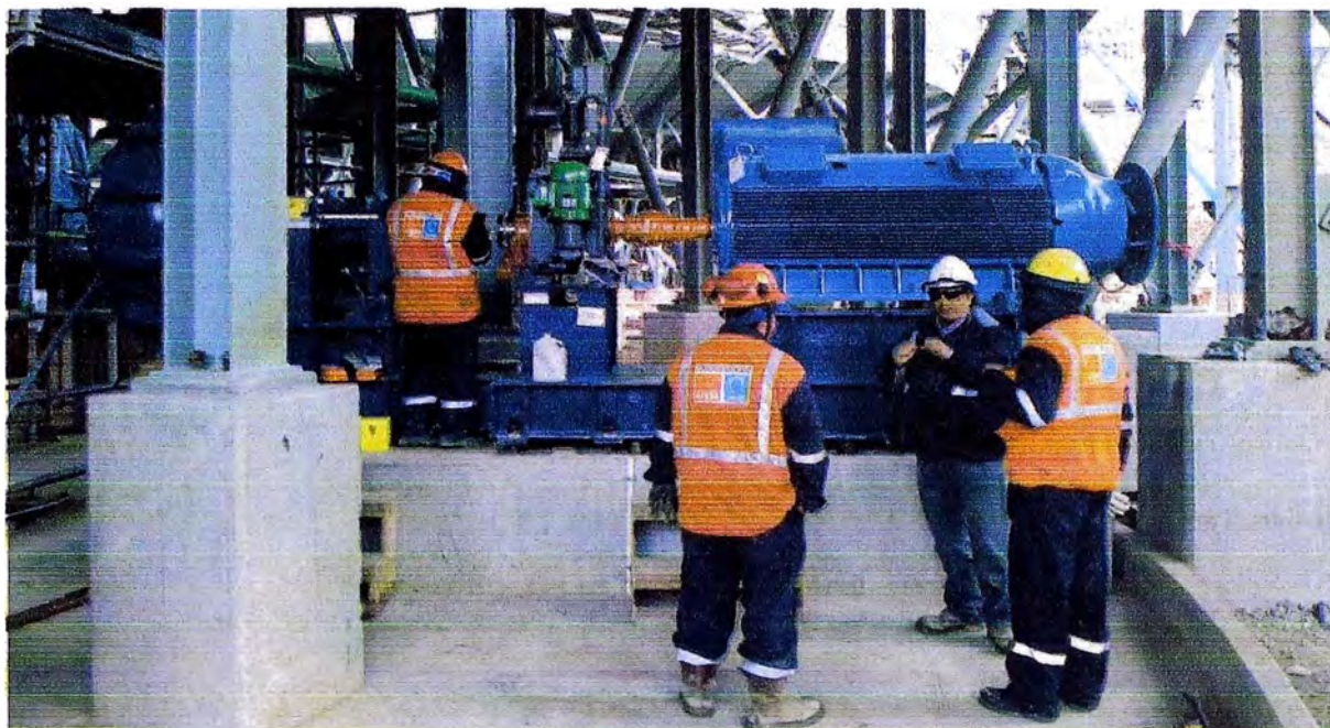
Figura 2.14: Ejemplo de instalación de acoplamiento entre bomba centrífuga y motor, trabajos de cierre en bomba centrífuga en planta concentradora Toromocho
