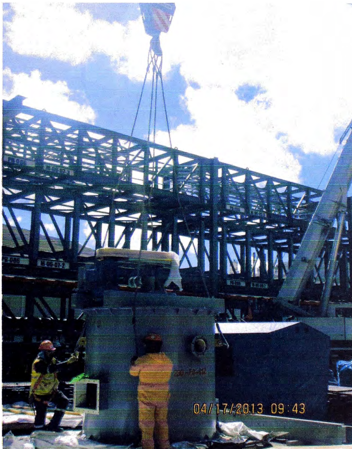
Figura 2.9: Ejemplo de montaje de celda y motor de hélice acoplado, montaje con grúa hidráulica en planta concentradora Toromocho
