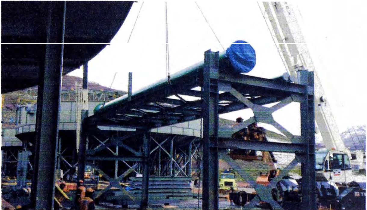
Figura 2.10: Ejemplo de montaje de tubería de 54" de acero al carbono con grúa hidráulica en planta concentradora Toromocho
