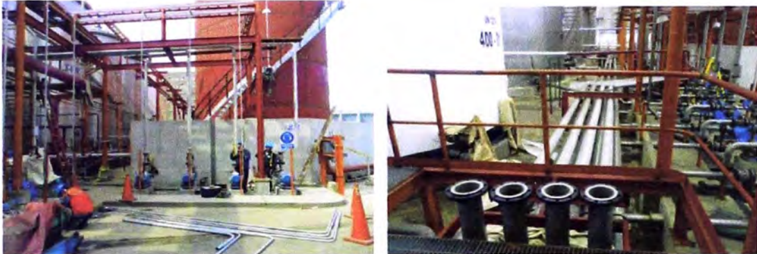
Imagen 30. Montaje de tuberías inoxidable
