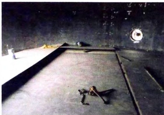
Imagen 23. Instalación de la plancha de fondo.
