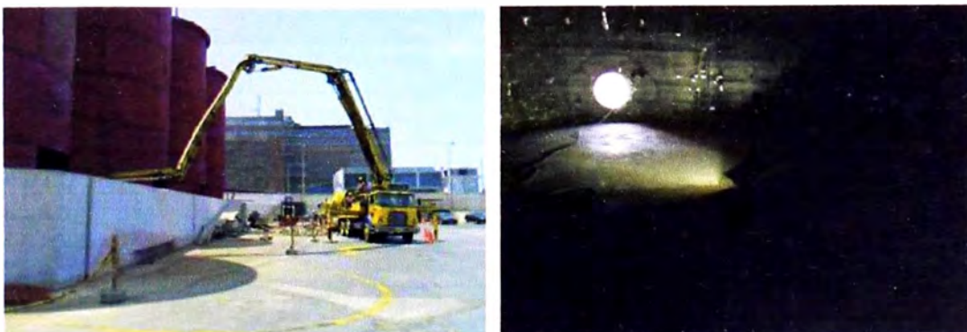
Imagen 22. Vaciado del fondo del tanque.
