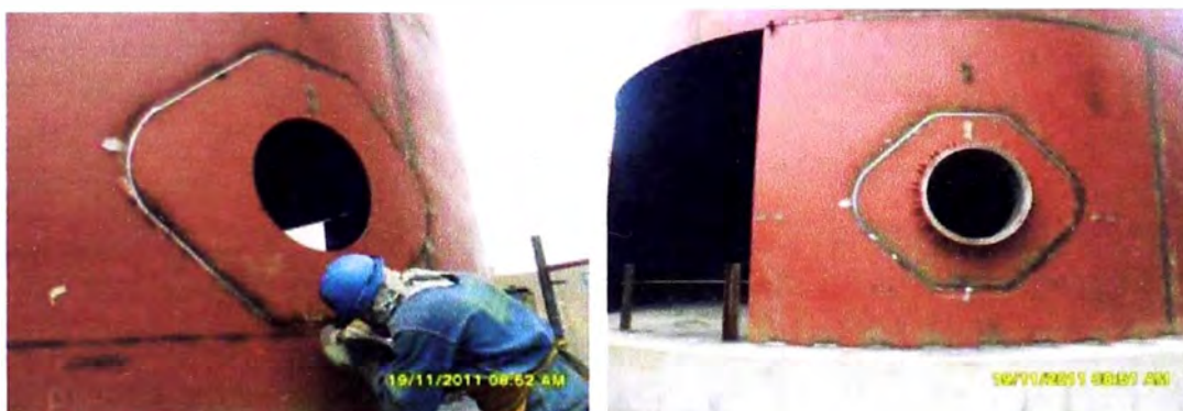
Imagen 24. Instalación de boca H1/H2 (Manhole costado)
