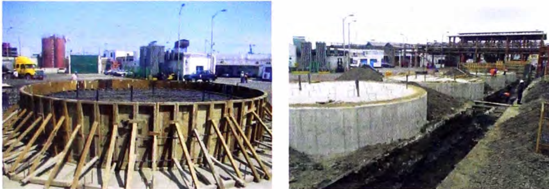
Imagen 12. Bases de concreto para tanques de 650m 3
