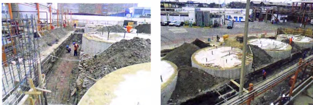
Imagen 13. Construcción dique de contención
