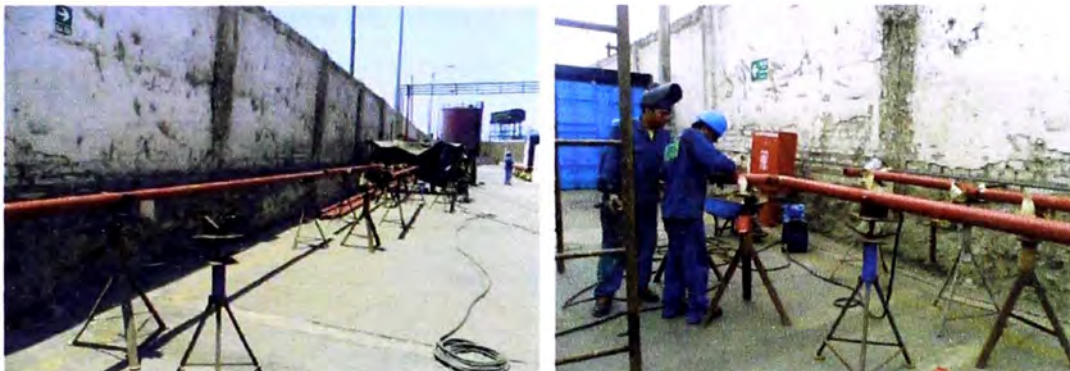
Imagen 28. Fabricación y montaje de tubería de carga y descarga
