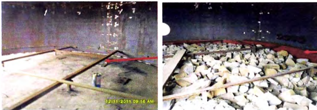
Imagen 21. Preparación del fondo y llenado con piedra para el vaciado.
