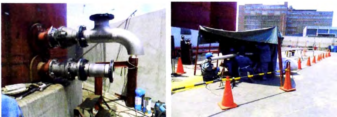
Imagen 28. Fabricación y montaje de tubería de carga y descarga
