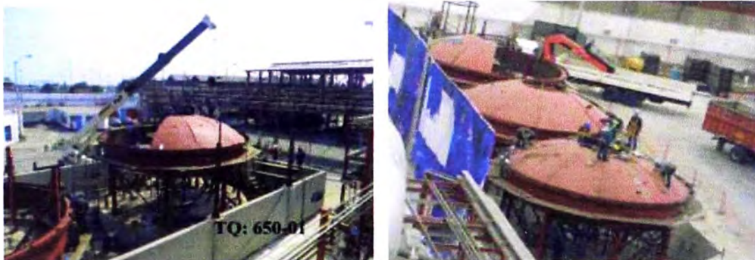
Imagen 16. Fabricación y montaje de techos de tanques
