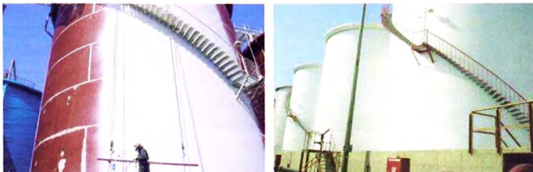
Imagen 32. Pintado de tanques
