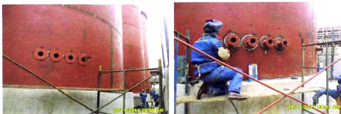
Imagen 25. Insatación de Bocas M1, M2, M3 y M4
