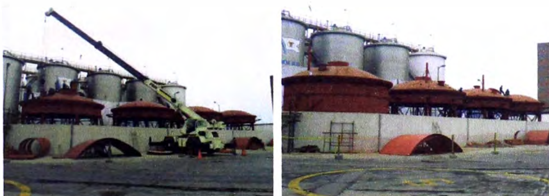
Imagen 17. Fabricación y montaje del 2do anillo
