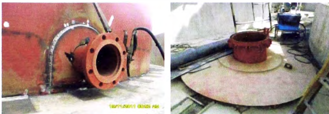
Imagen 26. Boca de Drenaje y Manhole techo
