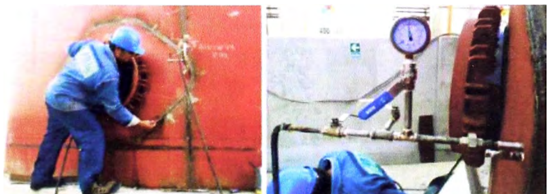
Imagen 34. Prueba neumática a plancha de refuerzo del Manhole H1
