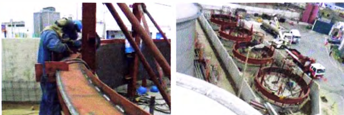
Imagen 15. Fabricación y montaje de anillo de compresión
