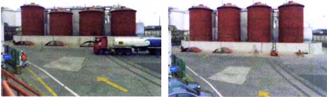
Imagen 19. Tanques con el 7mo anillo.
