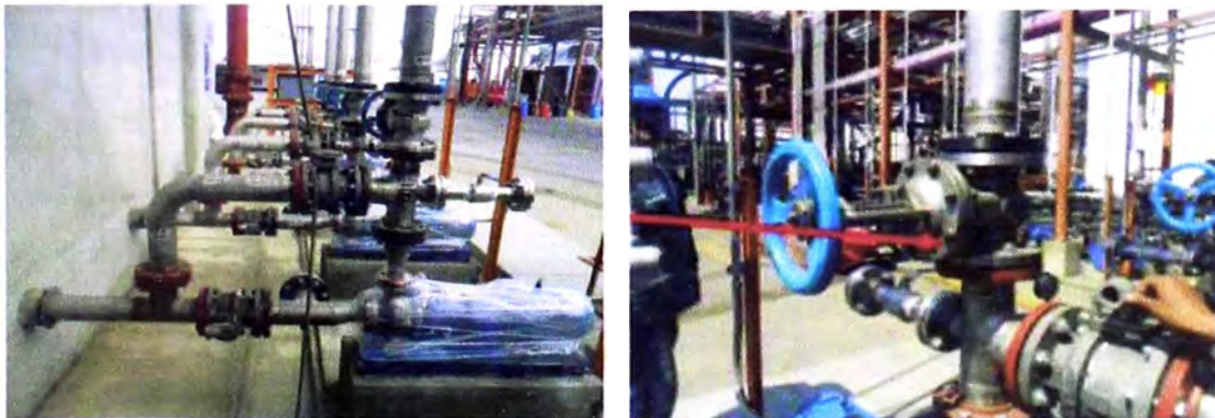
Imagen 31. Instalación de válvulas y bombas
