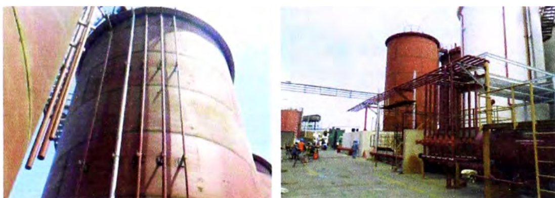
Imagen 29. Montaje de tuberías
