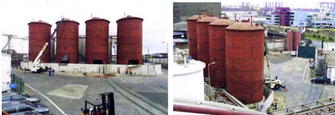
Imagen 19. Tanques con el 7mo anillo.
