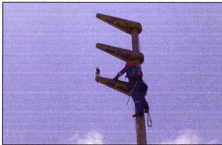
Figura N° 2.10: Instalación de accesorios de concreto. Fuente OPIC.
