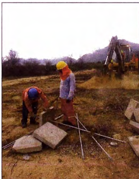
Figura N° 2.8: Instalación de accesorios de concreto. Fuente OPIC.
