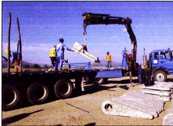
Figura N° 2.3: Descarga de accesorios de concreto en zona de izaje.
