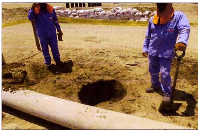
Figura N° 2.5: Excavación de hoyos para izaje de postes de concreto. Fuente OPIC
