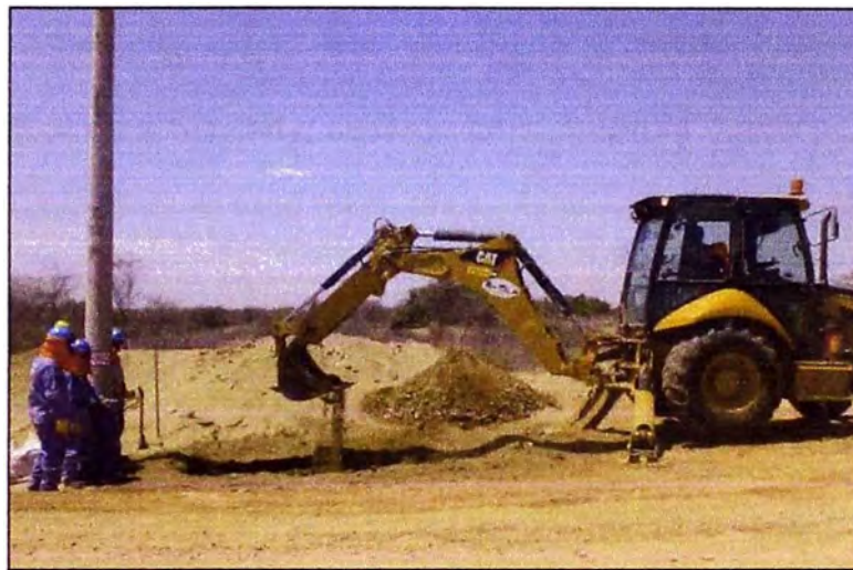
Figura N° 2.13: Excavación de terreno para instalación de PAT. Fuente OPIC.
