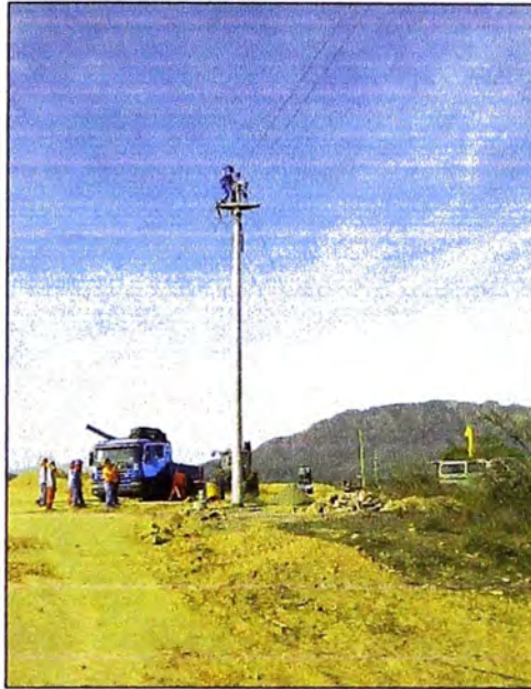
Figura N° 2.11: Pretendido de conductor aéreo. Fuente OPIC.
