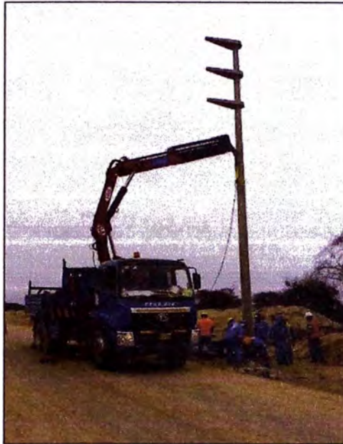
Figura N° 2.7: Instalación de accesorios de concreto. Fuente OPIC.
