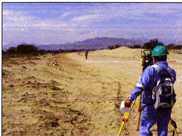
Figura N° 2.1: Replanteo Topográfico. Fuente Odebrecht Perú Ingeniería y Construcción (OPIC).
