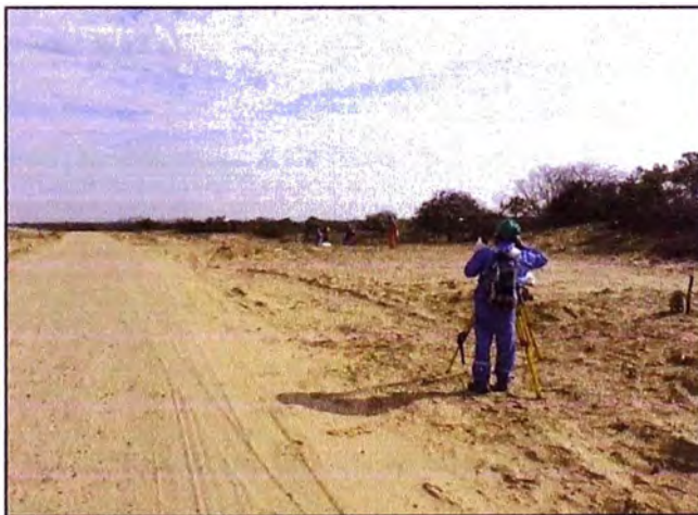
Figura N° 4.3: Replanteo Topográfico.
