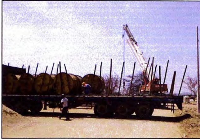
Figura N° 4.2: Carga de conductores eléctricos.
