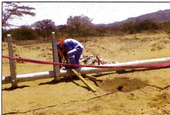
Figura N° 2.6: Instalación de accesorios de concreto. Fuente OPIC
