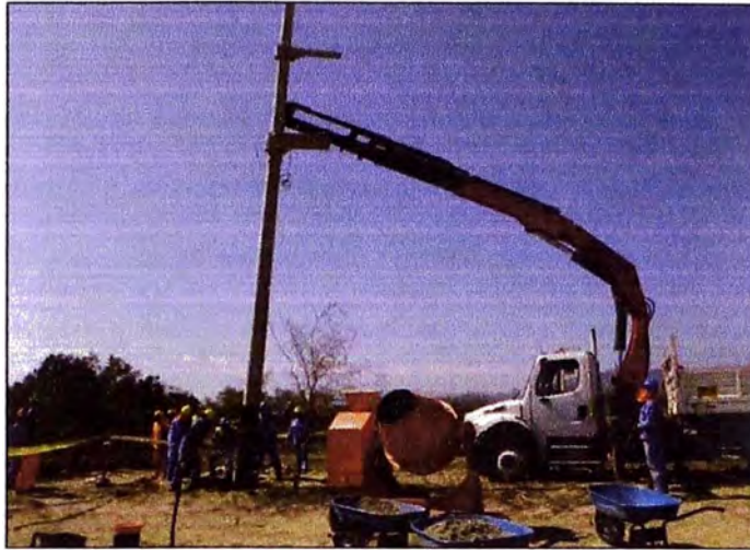
Figura N° 4.6: Falta de agua en la zona de trabajo.
