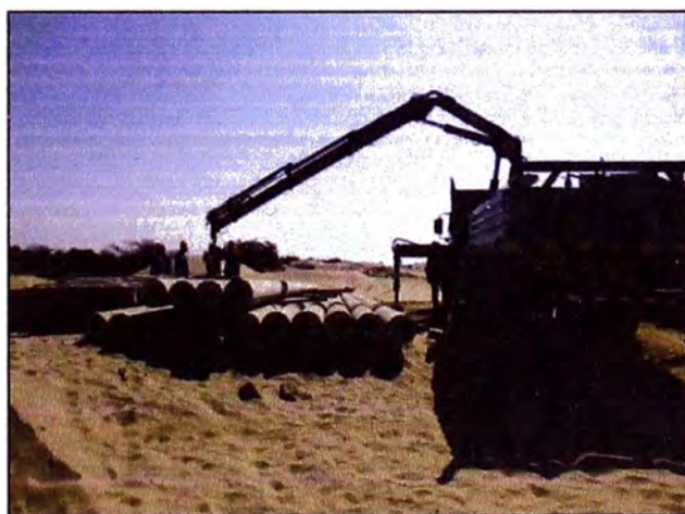
Figura N° 2.2: Descarga de postes de concreto en zona de izaje.
