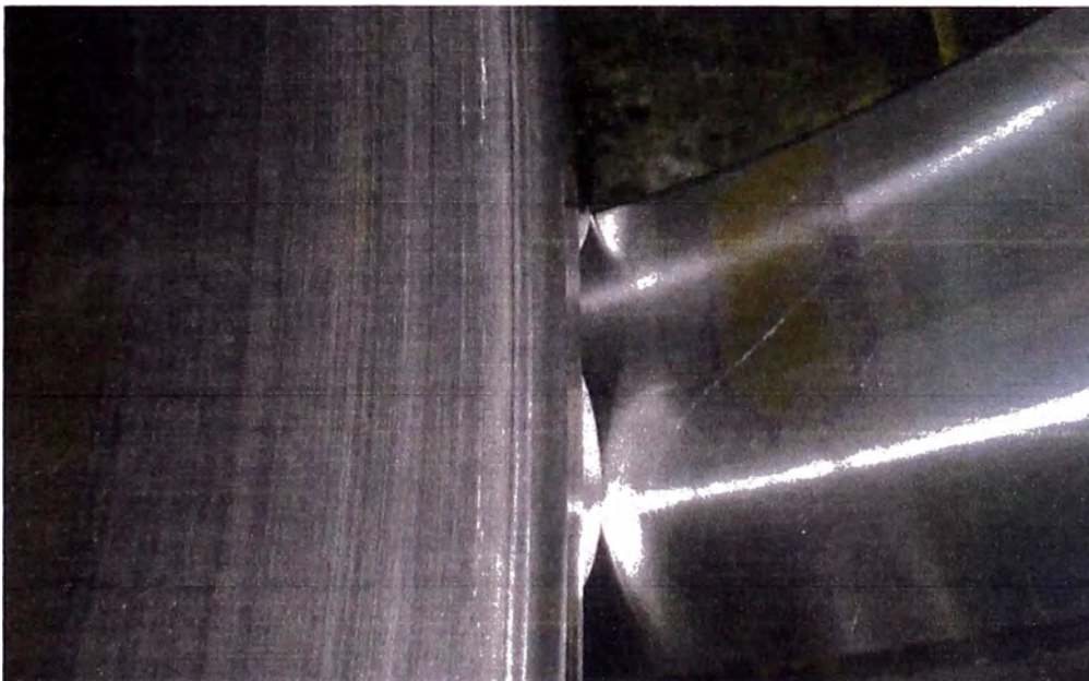
Fig. N°5.38 Marcas circunferenciales debido a microgiro por desgaste de superficie de agujero de aro interior respecto de eje.
