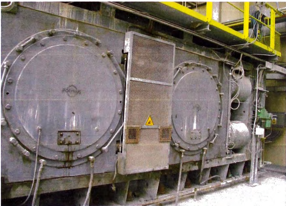
Fig. N°3.1 Chancadora terciaria rodillos-prensa lado operador (externo), posiciones B & D.
