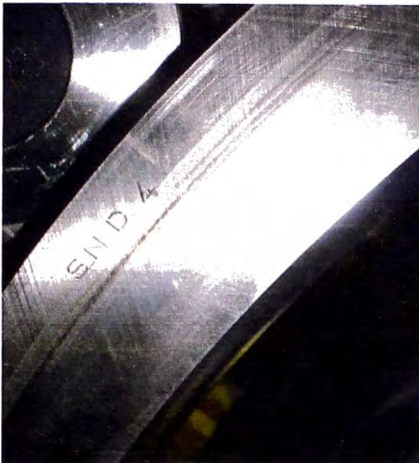
Fig. N°5.32 Número de serie SND4 grabado en lateral de aro interior.
