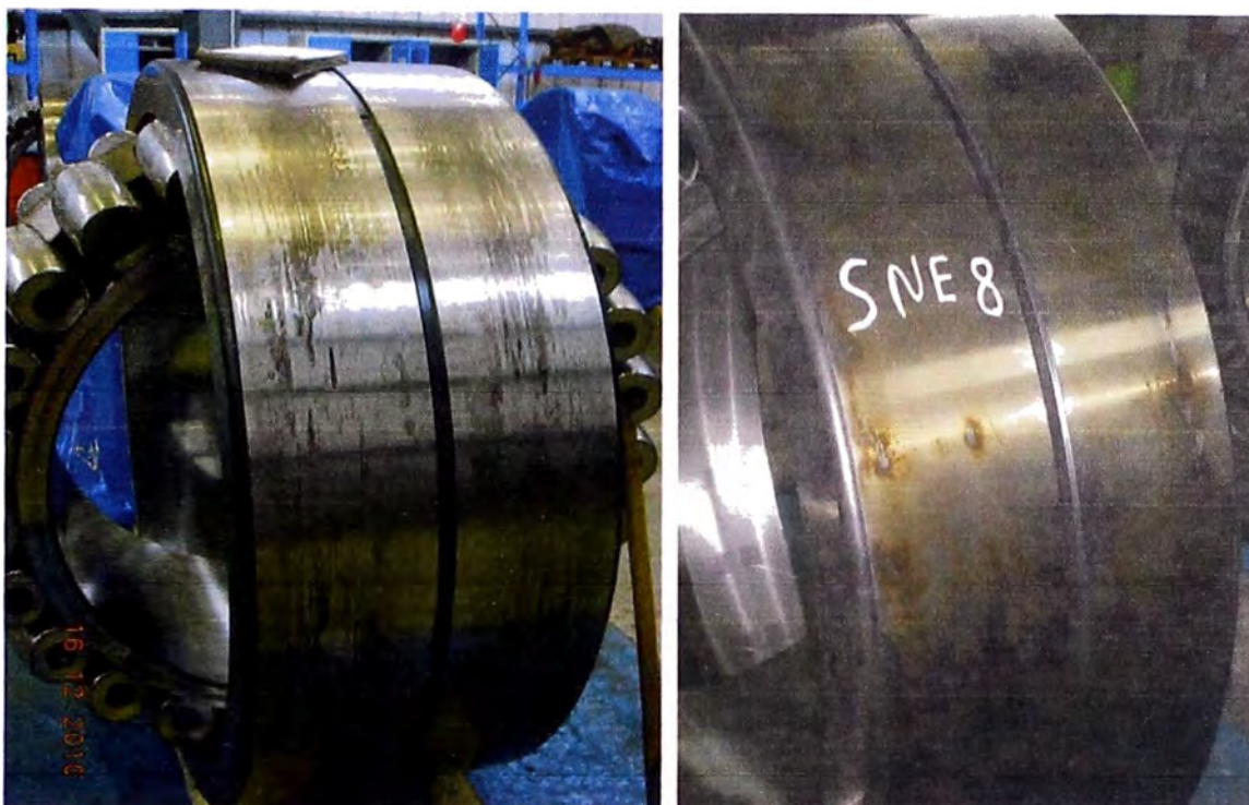
Fig. N°5.55 Oxidación de contacto (fretting corrosion) en varias locaciones de asiento de aro exterior por microgiros en alojamiento.
