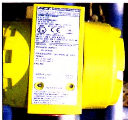
Fig. 3.6 Vista de datos de placa caudalímetro ST-75V
