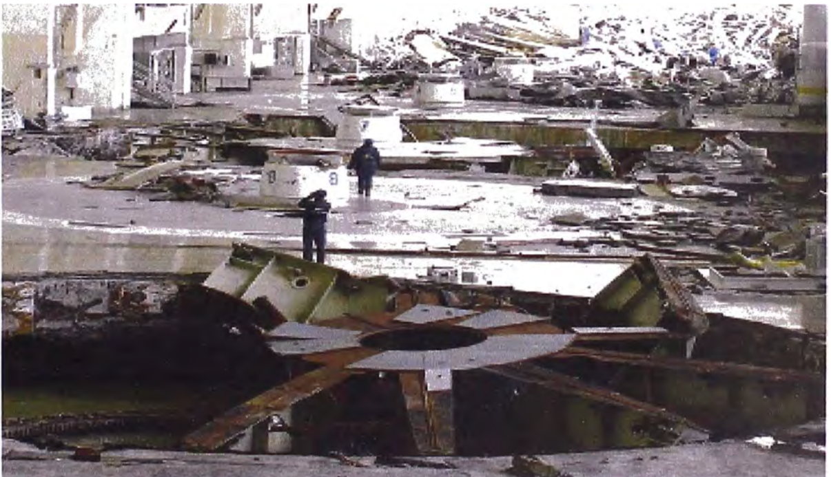
Fig.2. Daños causado en la parte alta de la central hidroeléctrica
