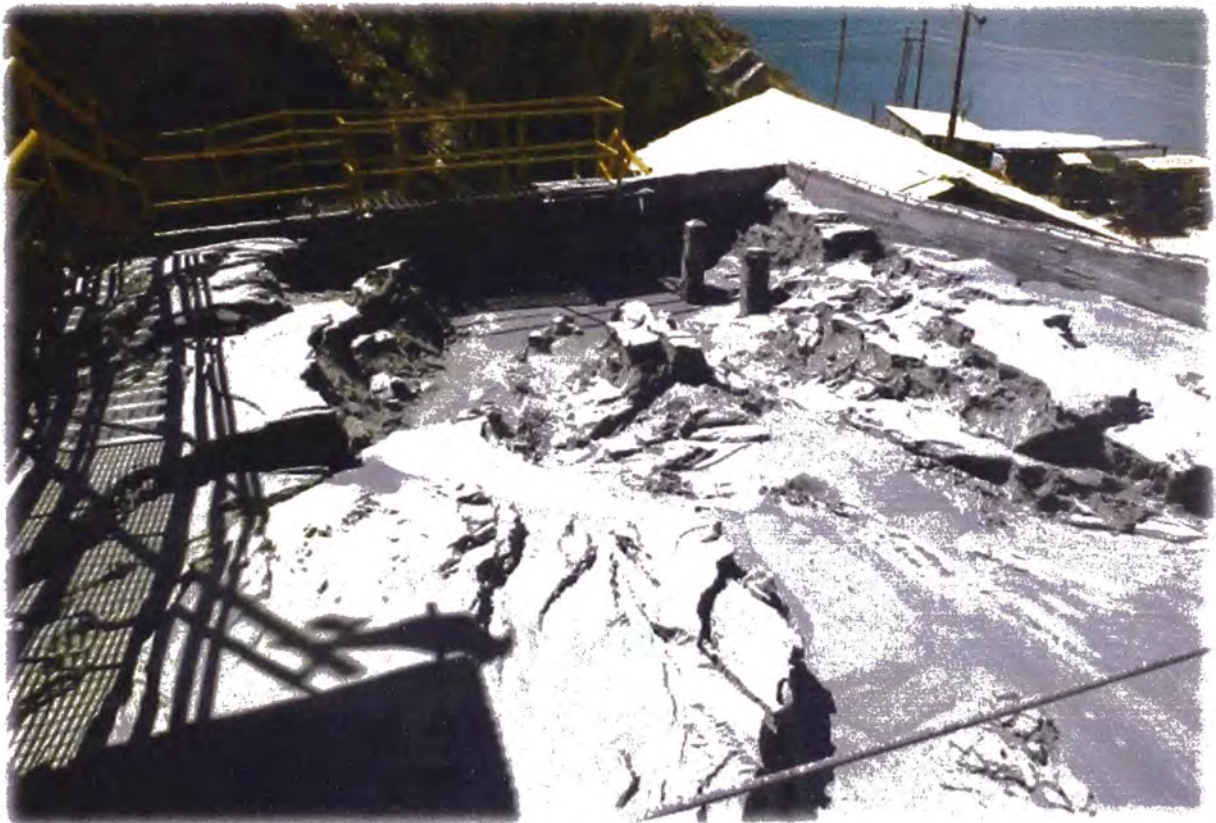
Fig. 1.3. Zona de preparación del relleno hidráulico en superficie.
