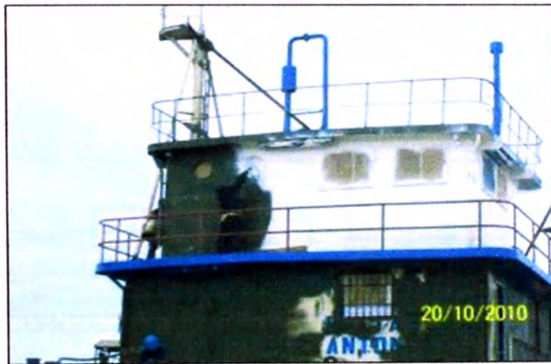
Foto 5.12. Pintado de sobre caseta
