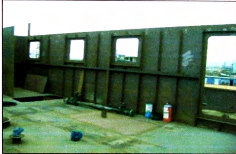
Foto 5.6. Puesta de caseta nueva
