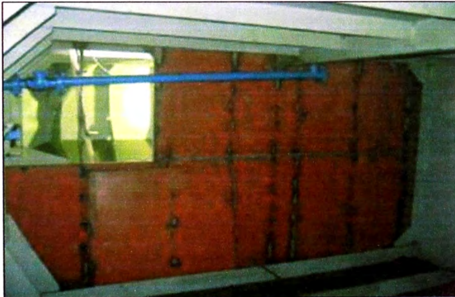
Foto 5.3. Mamparo estanco de piques
