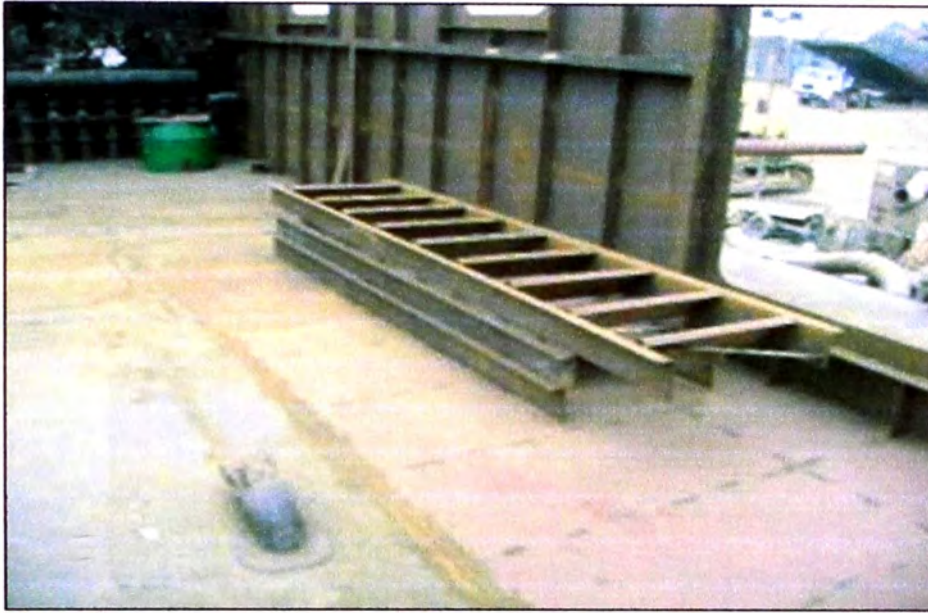
Foto 5.2 Puesta de tramo de cubierta principal
