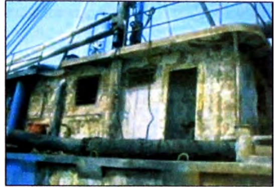
Foto 3.2 Daños en caseta popa
