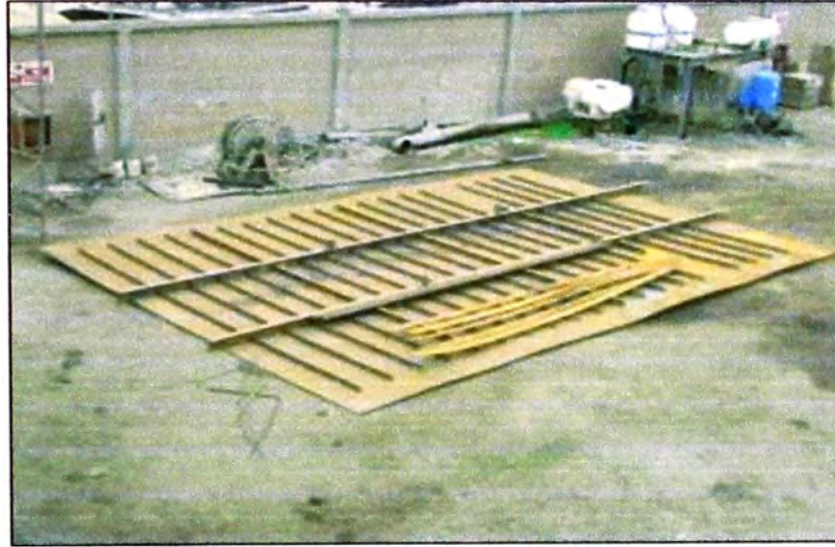
Foto 5.4. Cubierta de caseta
