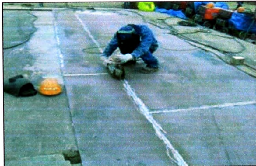
Foto 5.5. Soldadura de casco caseta
