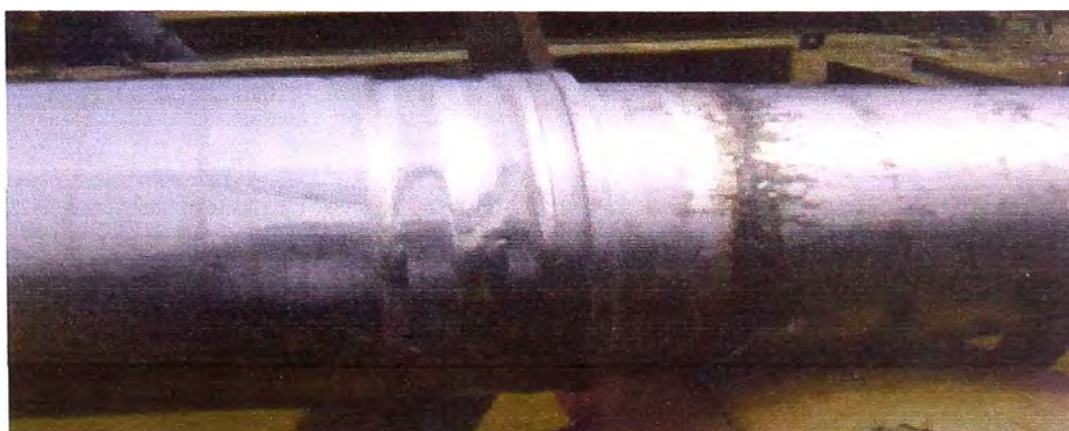
Figura 2.6 Luchadero arbotante eje estribor
