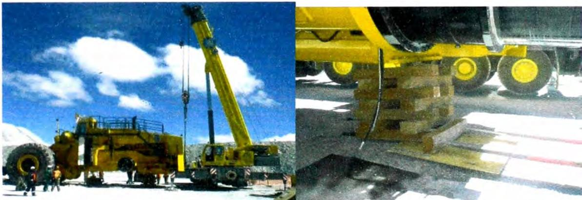
Fig. 6.22 Alzamiento de bastidor
