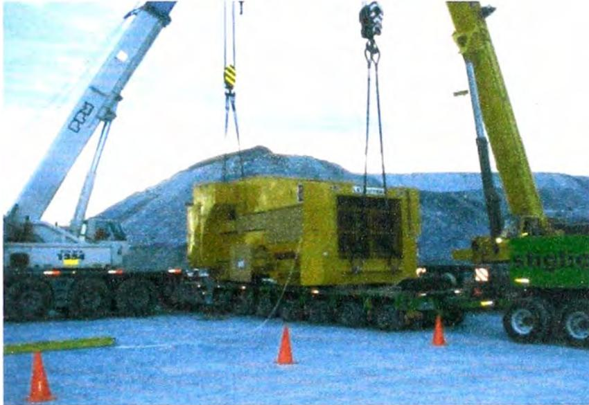
Fig. 6.2 Descarga del bastidor trasero
