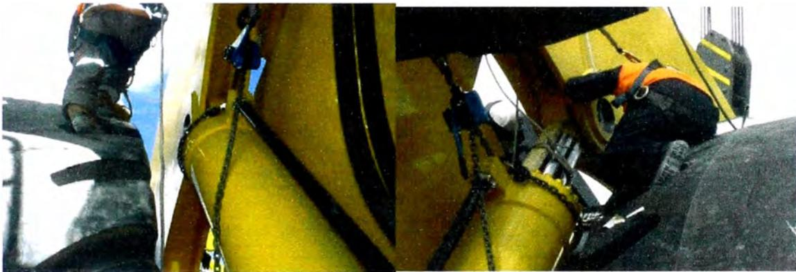
Fig. 6.28 Instalación de cilindros de levante
