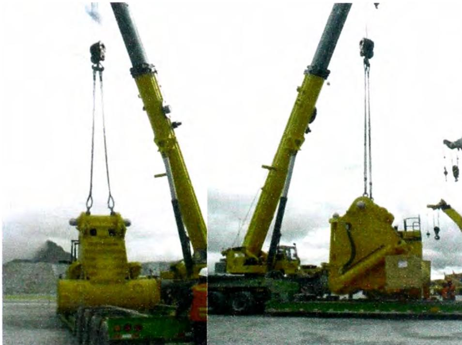
Fig. 6.3 Descarga del bastidor delantero
