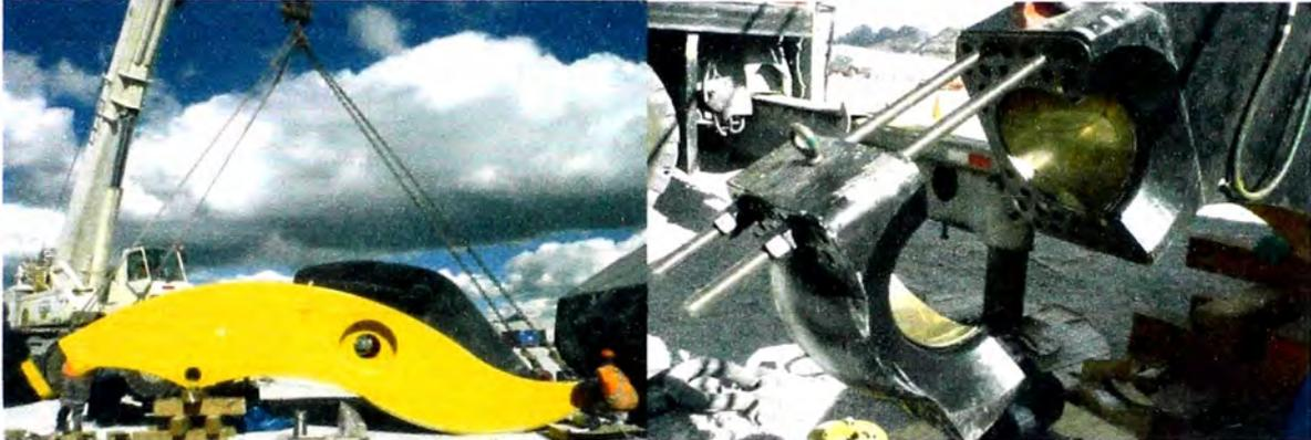
Fig. 6.25 Izaje de los brazos y preparación del punto de apoyo
