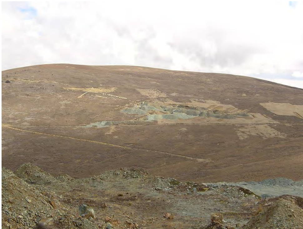
Foto 31.- Vista panorámica del área de Tomasa, apreciándose parte de las labores de minado superficial, además de las canchas de material estéril. (Vista tomada desde San Felipe con dirección Sur-Oeste).
