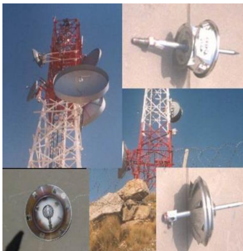
Ilustración 4.9 Desmontaje de pararrayos radiactivos
