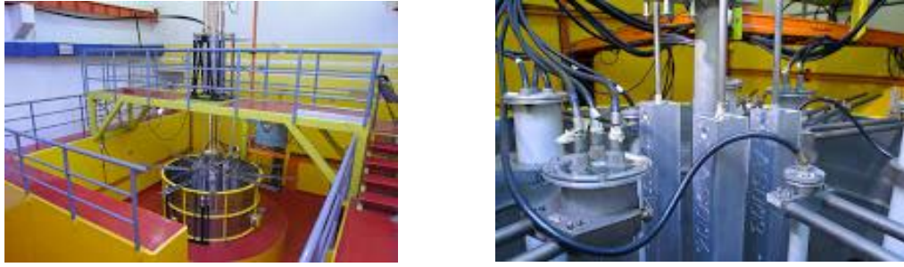
Ilustración 3.18: Instalación y núcleo del RP(0)
