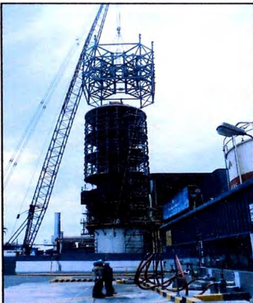
Fig. 4.21: Izaje Estructura de Ciclones
