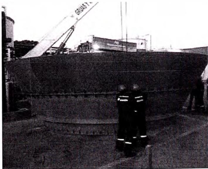
ARMADO Y SOLDEO DEL CONO INTERNO DE LA TRANSICION SOBRE CONO 03
