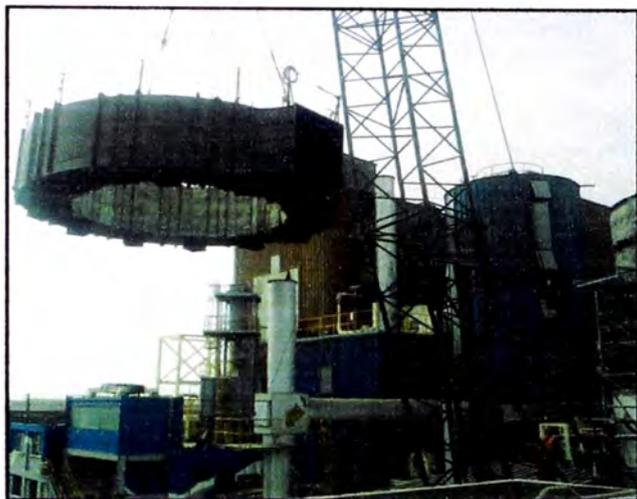
Fig. 4.13: Izaje del Anillo de Gas Caliente
