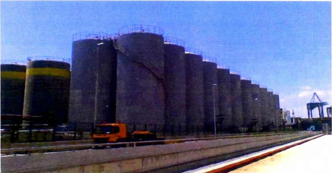
Figura 3.3 Tanque cilíndrico vertical fabricado de acero dúplex – España
