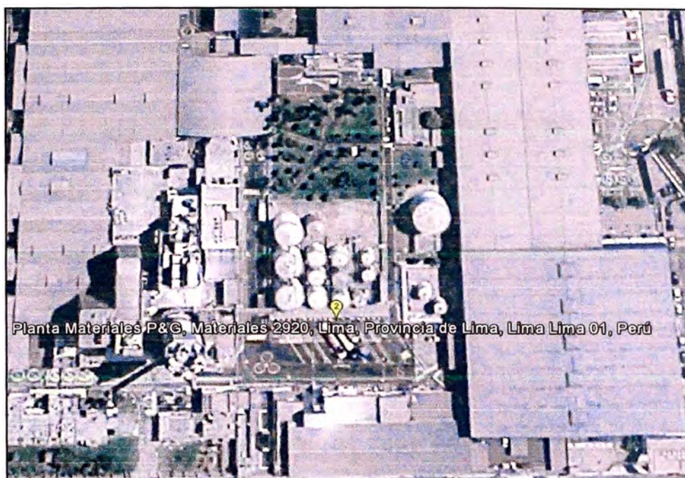
Fig. 1.1 Vista Satelital de la Planta
