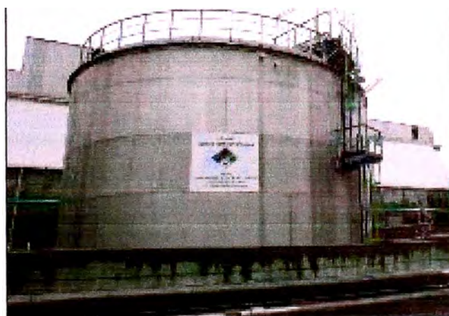
Fig. 5.4 Tanque de Óleum acondicionado
