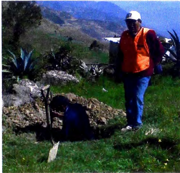
Elaboración de Calicatas
