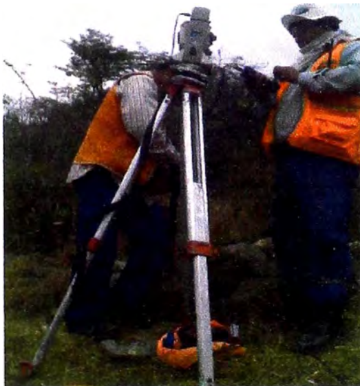
Personal de Topografía realizando el trazo de ruta con Estación Total
