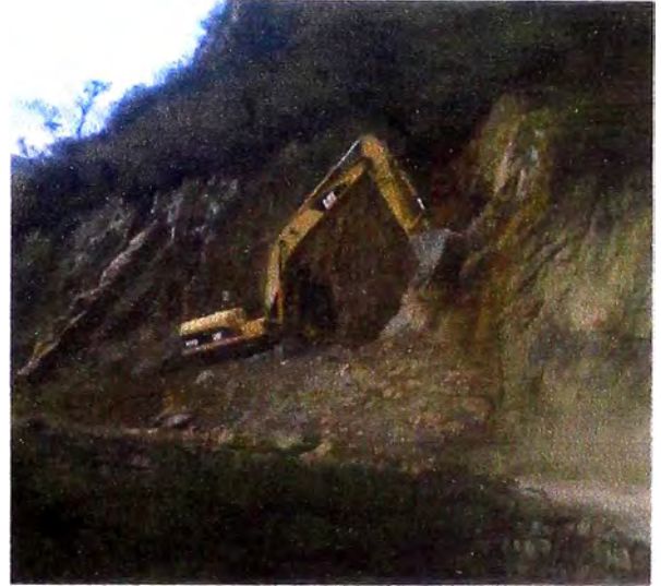
Trabajos de terceros en las trochas
