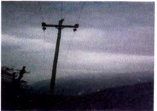
IE-Línea trifásica de 22.9KV en poste de madera en la localidad de Huabal
