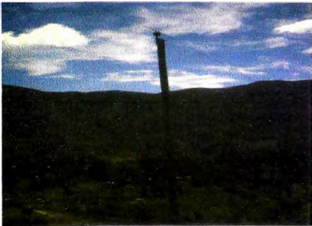
IE-Línea monofásica MRT de 13.2KV en poste de madera en la localidad de Pachani
