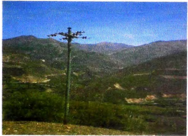
IE-Linea trifasica de 22.9KV en poste de madera en la localidad de Matara
