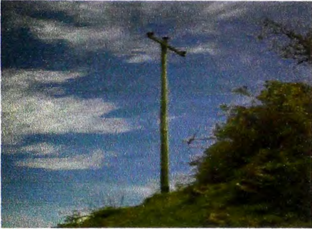
IE-Linea trifasica de 22.9KV en poste de madera en la localidad de Marra
