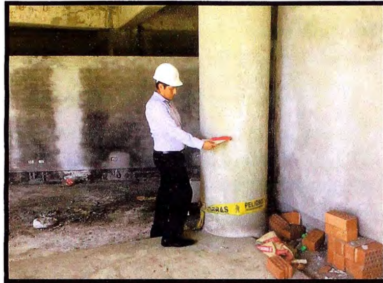
Figura N°4. 48: Medición de campo de iluminación
