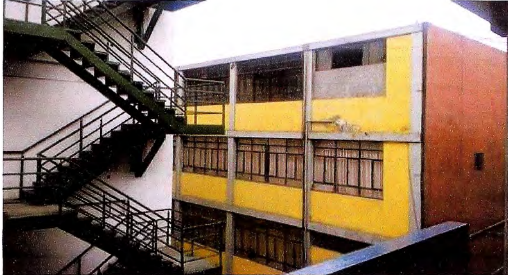
Figura N°4. 37: Perspectiva del pabellón G-5 en el año 2017.
