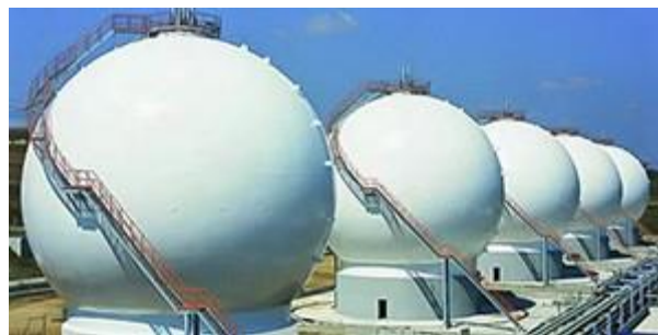
Figura 1.4 Tanque esférico sin columnas. (Fuente: www.cimtas.com )
