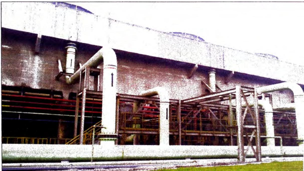
**Figura Nº 3.7** – Estación de bombeo del proyecto 320K actualmente trabajando. Los soportes de las tuberías fueron diseñados en Autocad, por tal motivo no se muestran en la maqueta PDMS.
