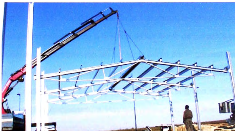
Figura 2.6 – Nave con armaduras.
