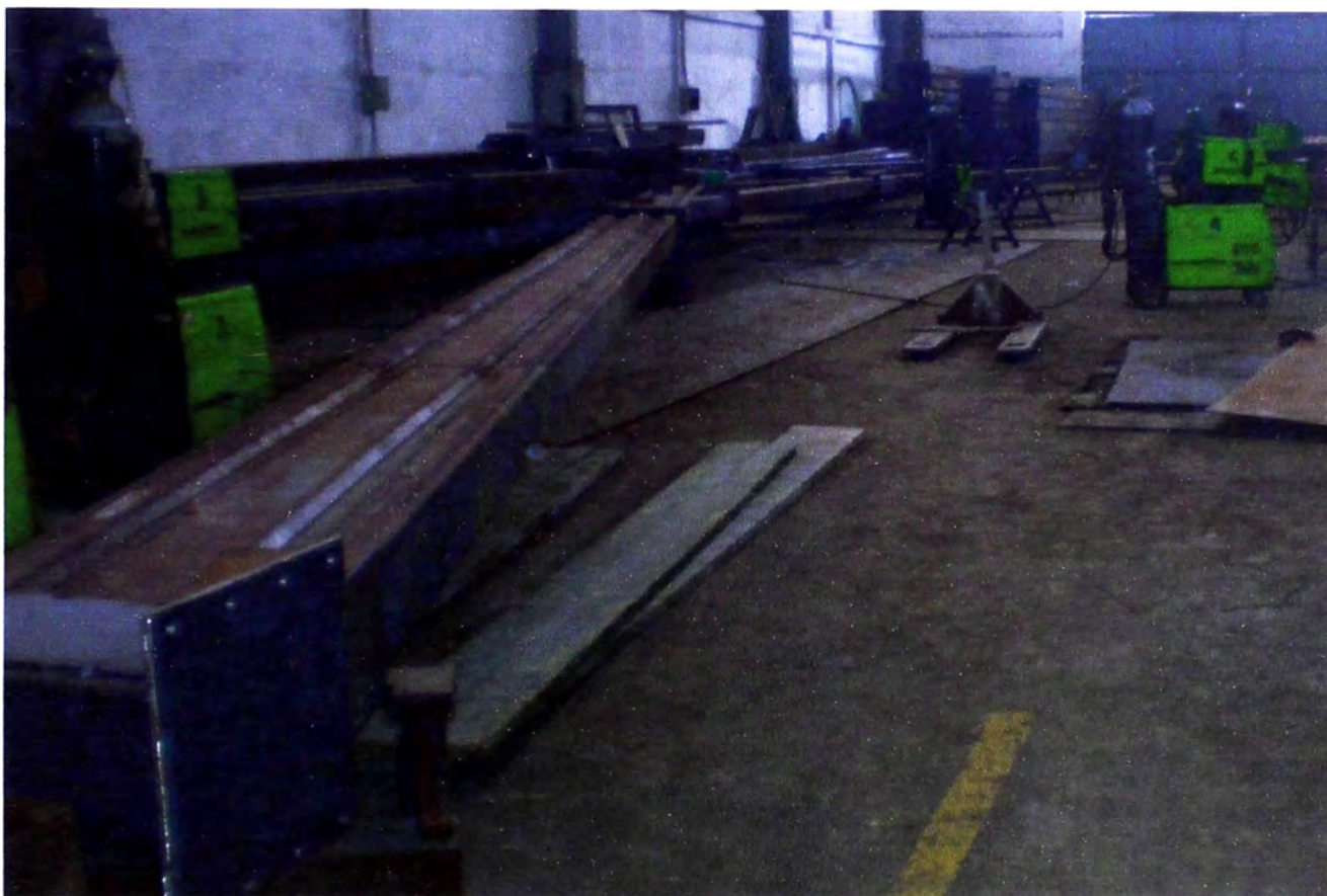
Figura 4.21 – Pre ensamble de vigas.
