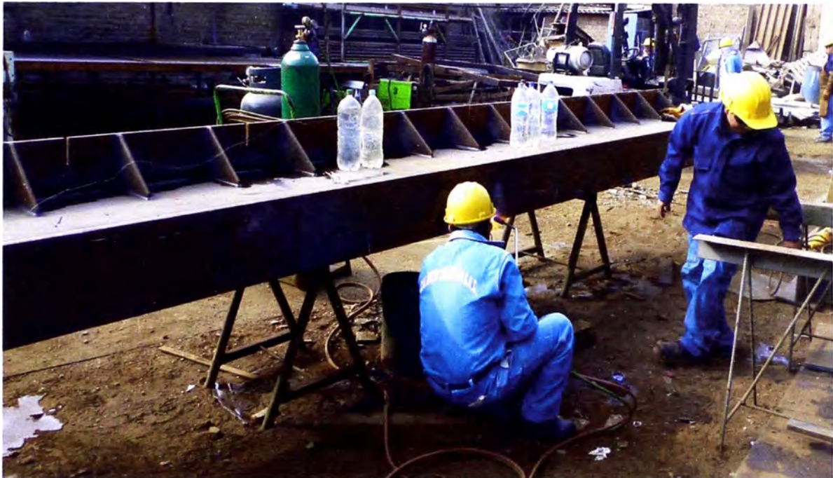
Figura 4.20 – Enderezado de una estructura metálica.
