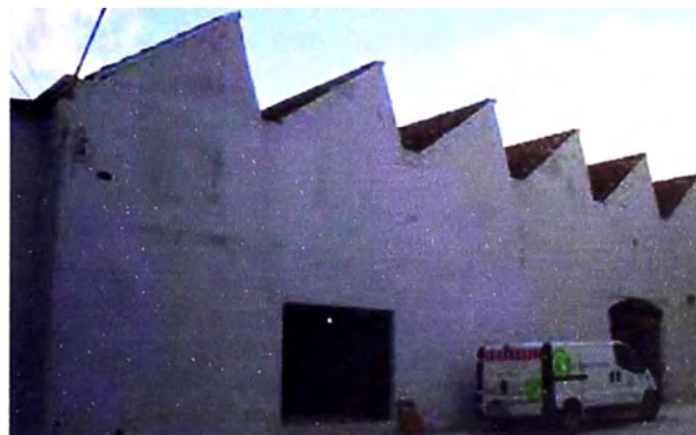
Figura 2.3 – Techo dientes de sierra.
