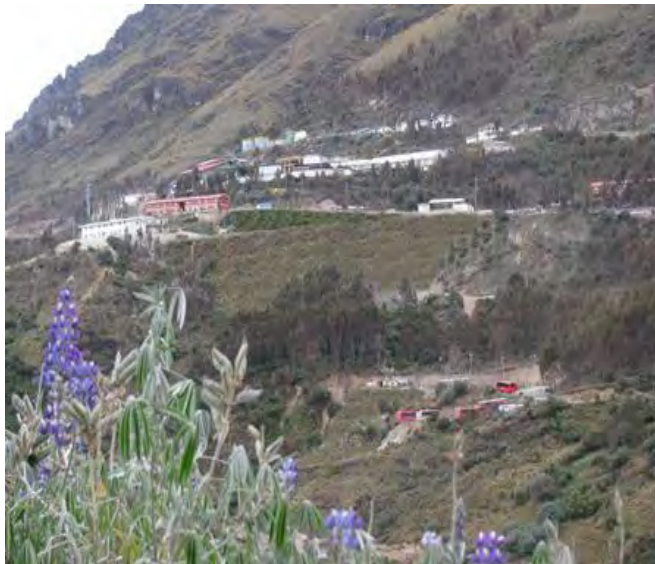
Figura 1.1: Vista panorámica de la Minera Aurífera Retamas S.A.
