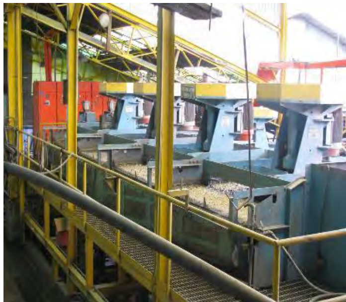
Figura 3.11: Instalación de las compresoras
