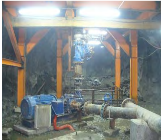
Figura 3.9: Instalación de tuberías de aire comprimido
