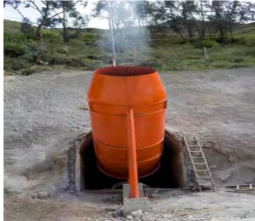
Figura 3.6: Sistema de ventilación
