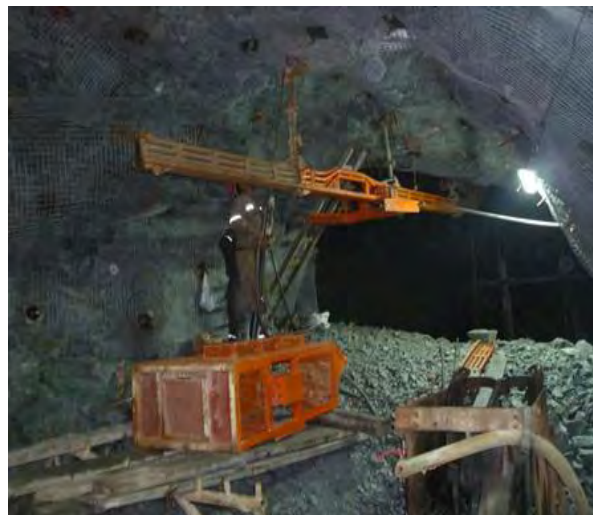
Figura 3.4: Perforación para voladura
