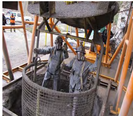
Figura 3.7: Ascensor de acceso al pique
