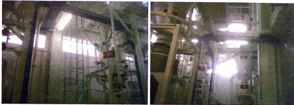
Fig. 5.7 Canaletas existentes por los silos de azúcar y harina del segundo piso.
