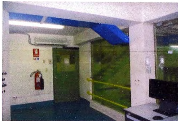
Fig. 5.10 Canaleta “PLC-2” Existente
