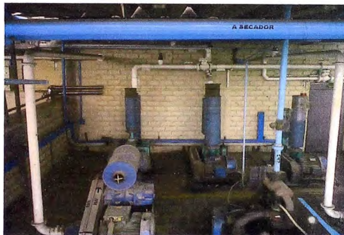
Fig. 5.8 Canaletas existentes en la sala de compresores del tercer piso
