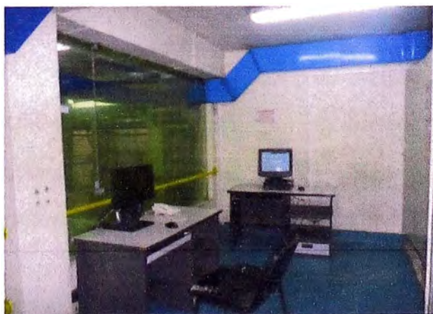
Fig. 5.9 Canaleta “PLC-1” Existente
