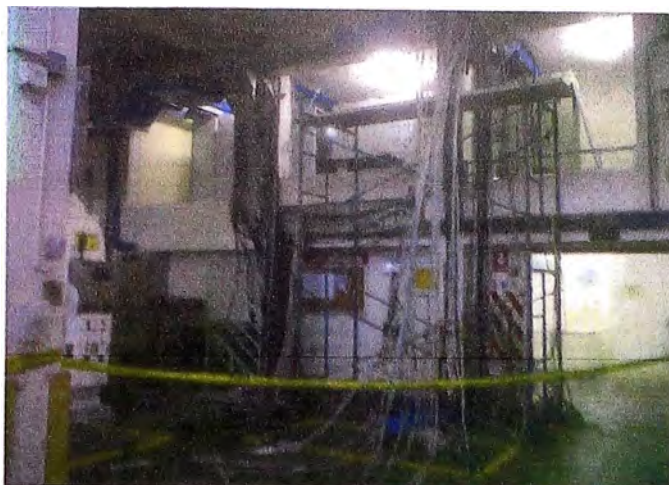
Fig. 5.3 Cables de Fuerza y control extendidos fuera de la sala de control Fuente: Propia
