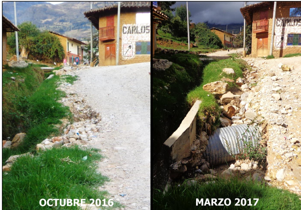
Fotografía 3.2. Proceso de disgregación por acción de las aguas pluviales en el camino hacia el Ojo de Lanla
