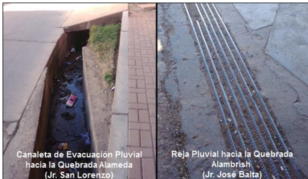
Fotografía 4.1. Estructuras pluviales existentes en el Sector 1
