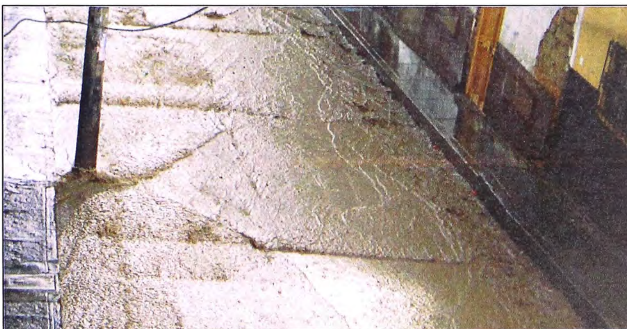
Fotografía A.2. Poste de alumbrado público, dentro de la calzada, genera un remanso en un extremo de la vía por encima del nivel de la vereda, ocasionando el ingreso de escorrentía hacia las viviendas. Fuente: Fotografía propia. (2016, Octubre 15).
