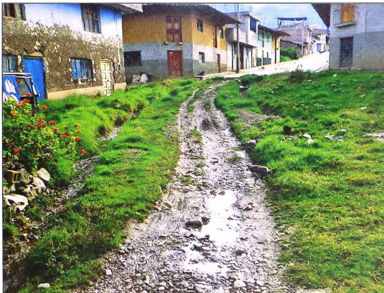
Fotografía A.8. Encharcamiento que ocasiona la proliferación de vectores (zancudos, mosquitos, etc.) de enfermedades metaxénicas.
