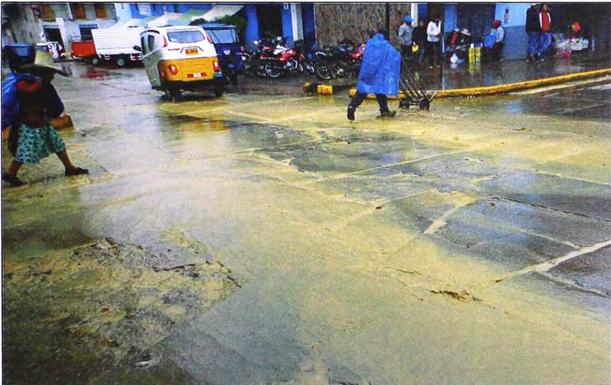
Fotografía A.4. La escorrentía superficial afecta directamente a los transeúntes y al comercio en las calles aledañas al mercado central de la ciudad de Cajabamba. Fuente: Fotografía propia. (2017, Marzo 29).
