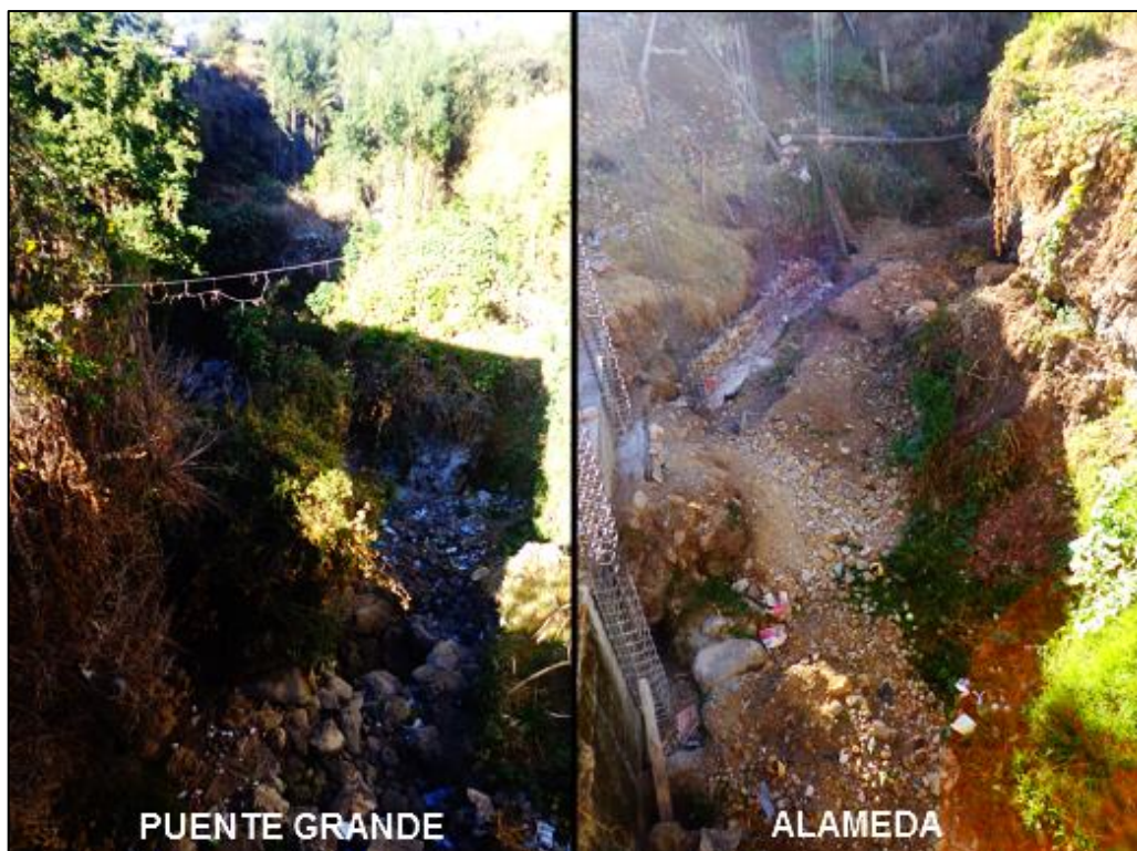
Fotografía 3.4. Profundidad de los cauces de las quebradas Puente Grande y Alameda
