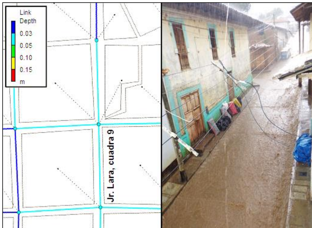
Figura 3.23. Nivel de escorrentía superficial en la cuadra 9 del Jr. Lara
