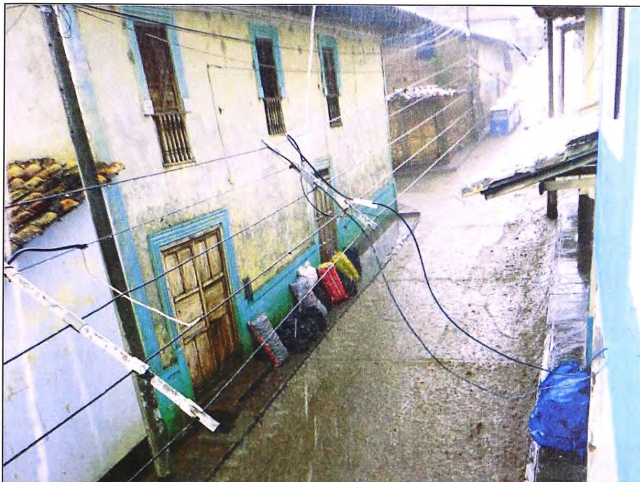
Fotografía A.1. Calzada intransitable en el Jr. Lara debido a una precipitación intensa. Fuente: Fotografía propia. (2016, Octubre 15).
