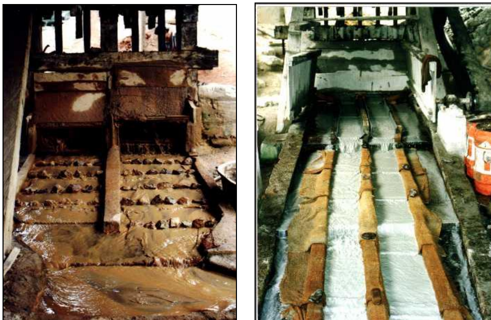
Figura N° 54: Estado Inicial Canaletas y Reforma Canaletas
