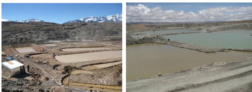
Figura N° 47: Pozas de sedimentación en circuito cerrado y tratamiento físico de aguas procedentes del beneficio mineral en Ananea
