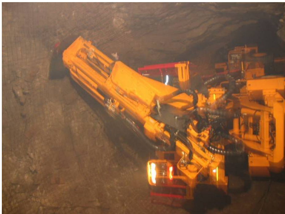
Empernador terminando la instalación de un perno mecánico
