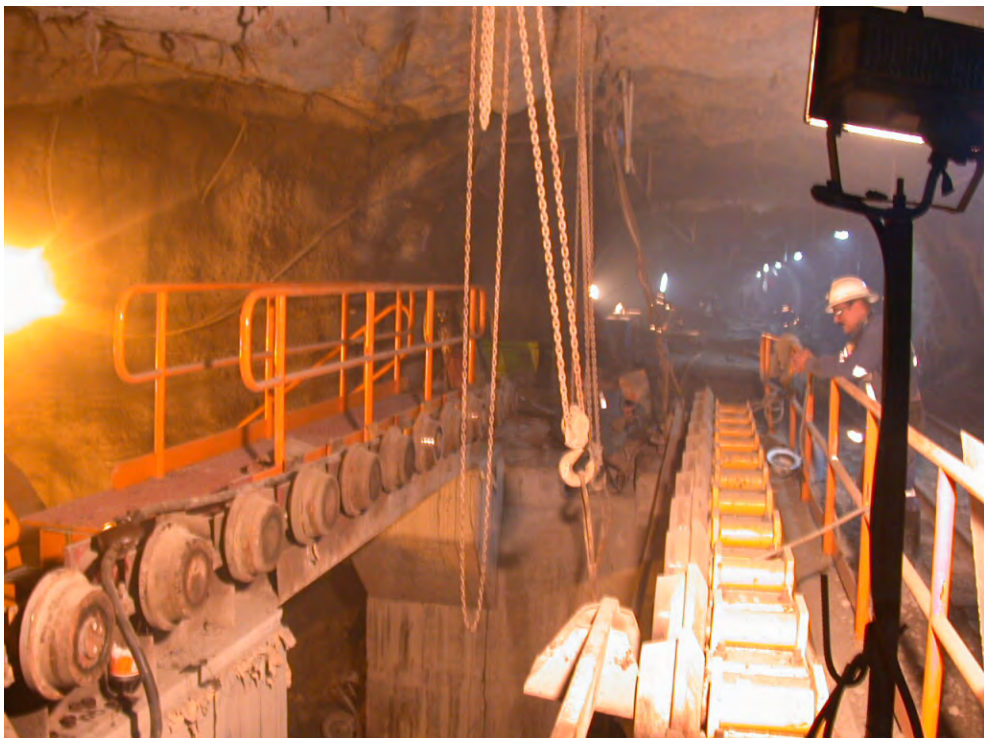
Zona de descarga de la locomotora (Nivel -1170)
