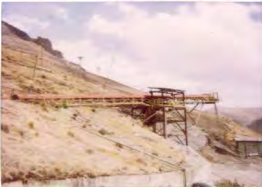
Faja que acumula el Mineral en el Stock Pile (Nivel 0)
