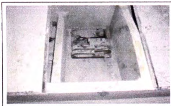
Figura 4.16 Caja de regulación mecánica, donde se colocan las laines
