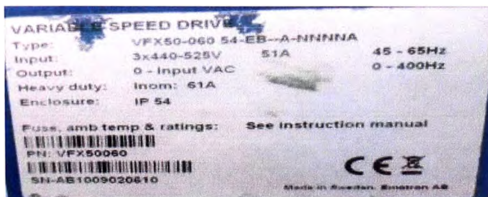
Figura 4.14 Datos técnico del variador de velocidad
