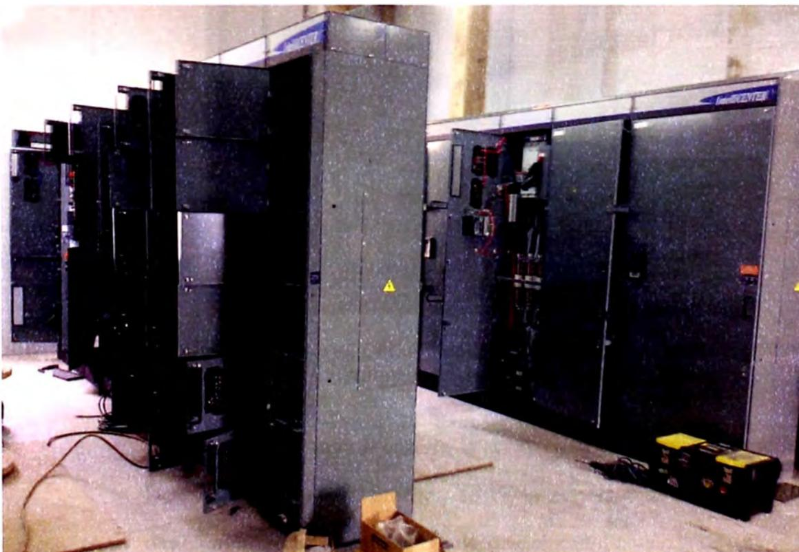
**FIGURA 4.2.** Vista de dos CCMs DeviceNet en proceso de inspección física.
