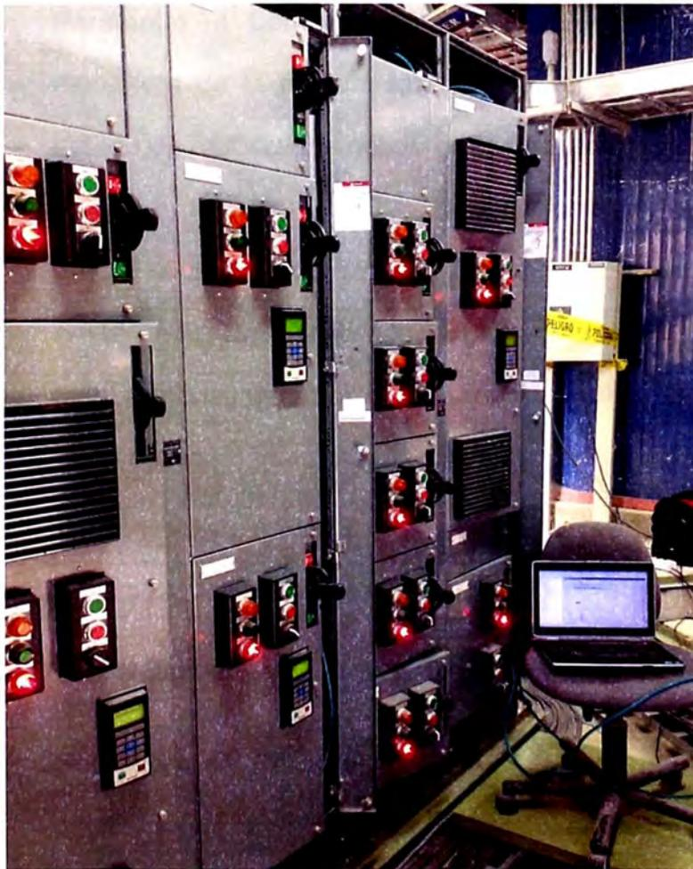
**FIGURA 4.17.** Conexión de laptop con CCM Ethernet/IP.
