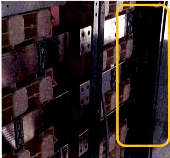
**FIGURA 4.3.** Vista posterior de un CCM. Nótese la unión de las columnas realizada en las instalaciones del cliente.
