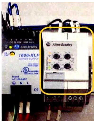
**FIGURA 4.11.** Relés de monitoreo 813S (a la derecha). Nótese las cuatro perillas que permiten la configuración de estos relés.
