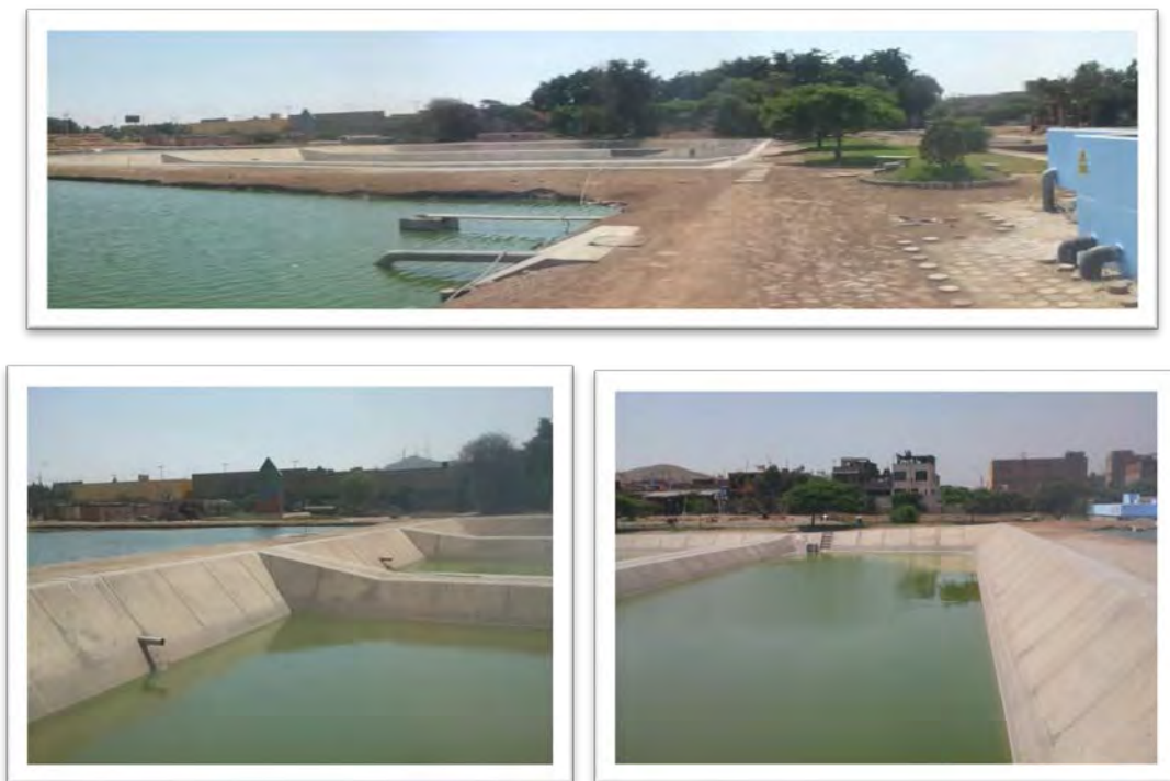
Figura Nº 2.07. Lagunas de estabilización.
