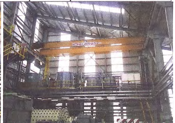
Foto 12: Puente grúa de 25t, instalado en el área de Molienda
