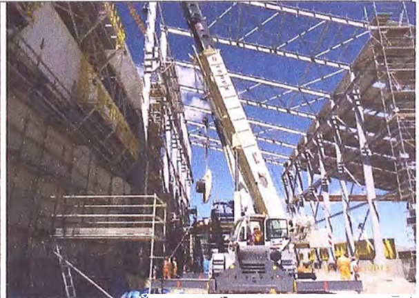
Foto 6: Montaje de la tapa de carga del Molino de Bolas
