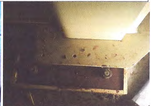
Foto 10: Aplicación de grout epóxico, Chockfast Red para los soleplates del Molino de Bolas
