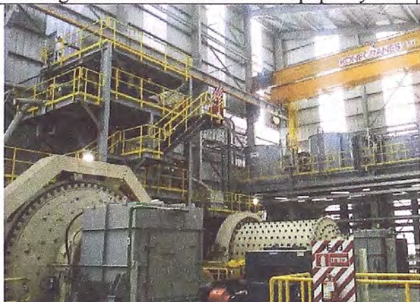
Foto 11: Molino de Bolas y Barras (Izquierda y derecha), al culminar el montaje e instalación
