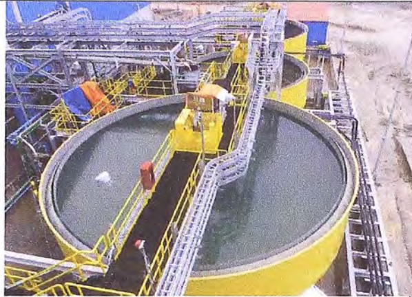
Foto 13: Prueba de estanqueidad de Espesadores de Zn, Pb y Cu
