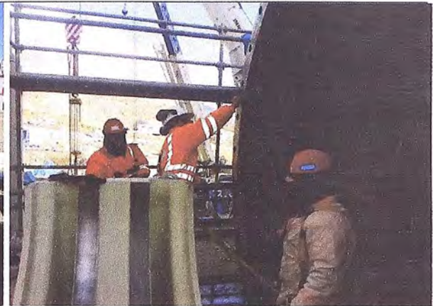
Foto 8: Verificación de la planitud de la brida del Shell en la zona de empalme con la tapa de carga del Molino de Barras
