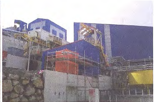
Foto2: Nueva Planta Concentradora, vista desde otro ángulo
