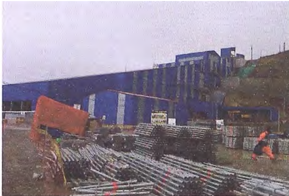
Foto1: Vista General de la Nueva Planta Concentradora-Alpamarca
