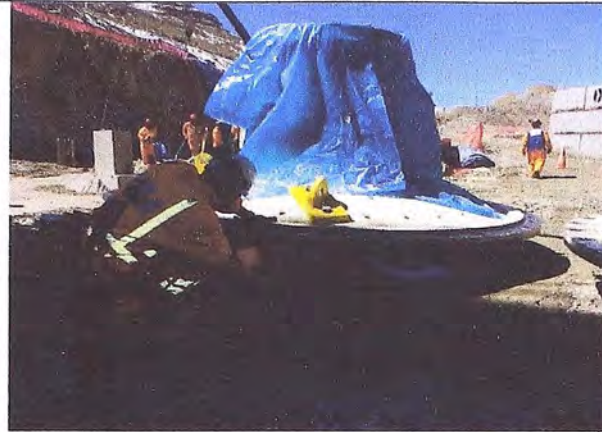
Foto 7: Verificación de la planitud de la tapa de carga del Molino de Barras, usando regla de pelo
