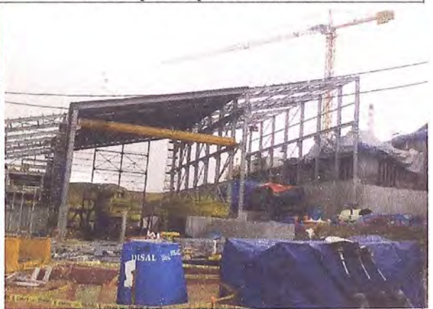
Foto 19: En la imagen se observa los edificios de Flotación y Molienda (De izquierda de derecha)
