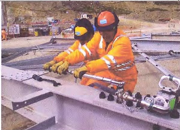
Foto 18: Verificación del torqueo de pernos estructurales de pórticos en la zona de pre-ensamble
