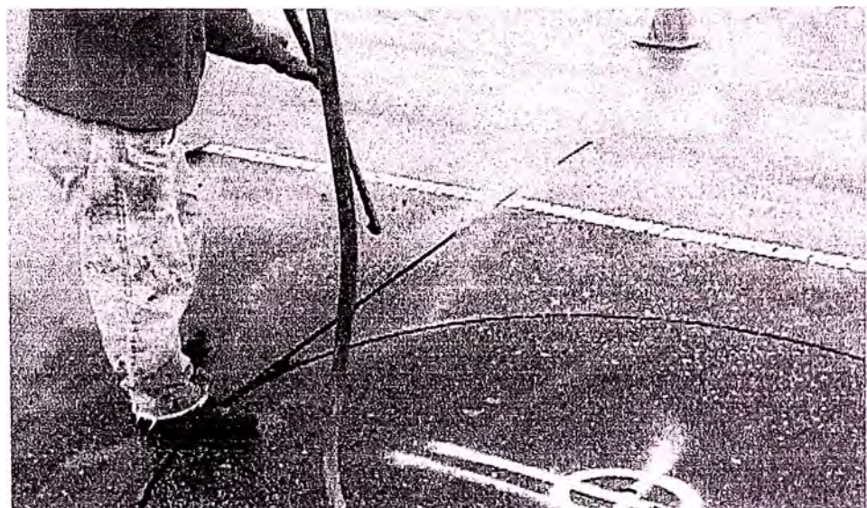
Figura N°20: Sopletear el Canal
