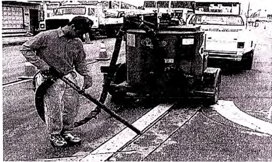
Figura N°22: Sellador para el Detector
