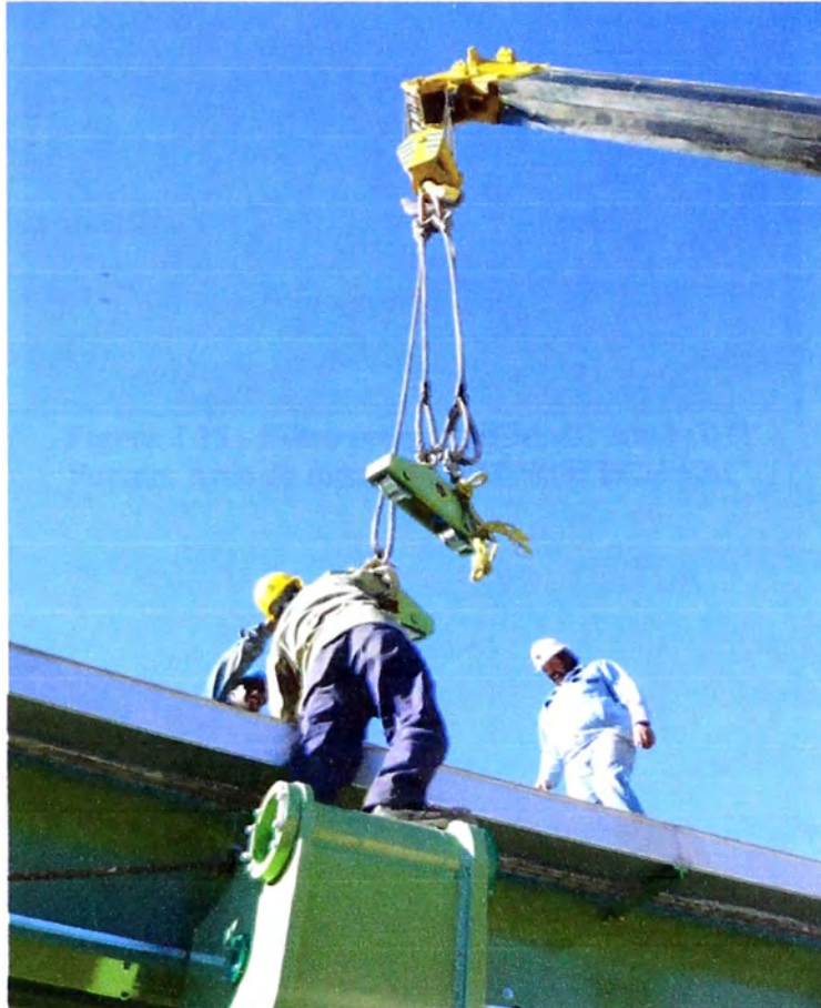
Figura 3.14 Instalación de placas - filtro prensa DIEMME 2000 GHT Fuente: Área de montaje CEMPROTECH SAC.
