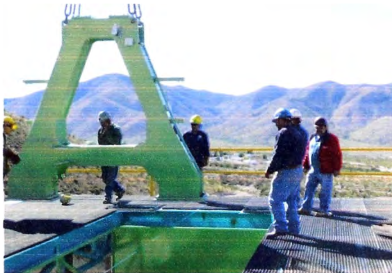
Figura 3.10 Cabezal móvil filtro prensa DIEMME 2000 GHT Fuente: Área de montaje CEMPROTECH SAC.
