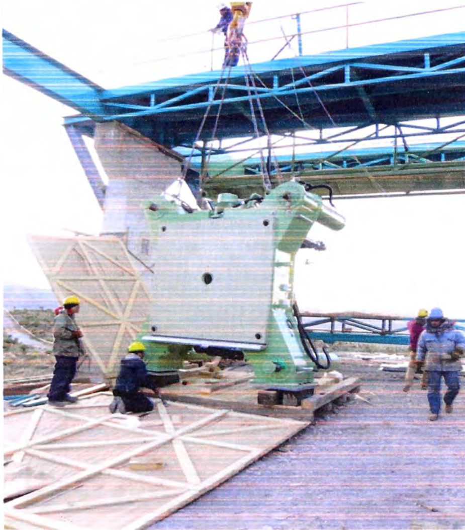
Figura 3.7 Cabezal fijo - Filtro prensa DIEMME 2000 GHT Fuente: Área de montaje CEMPROTECH SAC.
