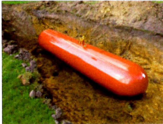
Figura N° 1: Tanque con recubrimiento anticorrosivo.
