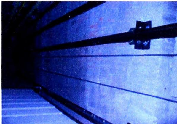
Fig. 2.4 Guías de carro cabina y contrapeso.
