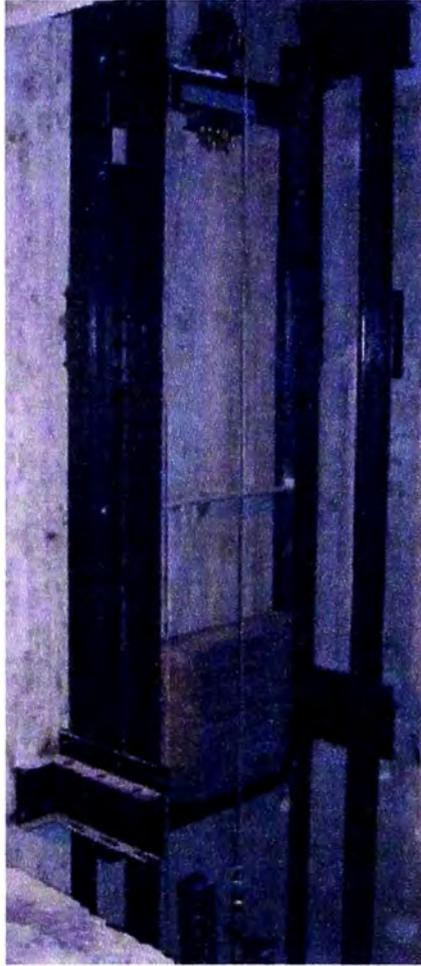
Fig. 2.12 Chasis del contrapeso y los bloques fundidos.
