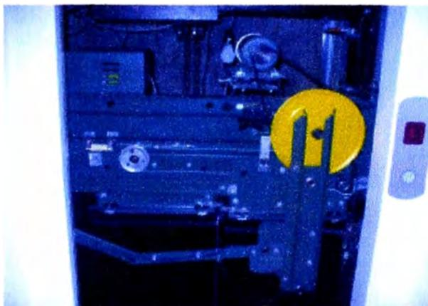
Fig. 2.11 Operador de puerta de cabina.
