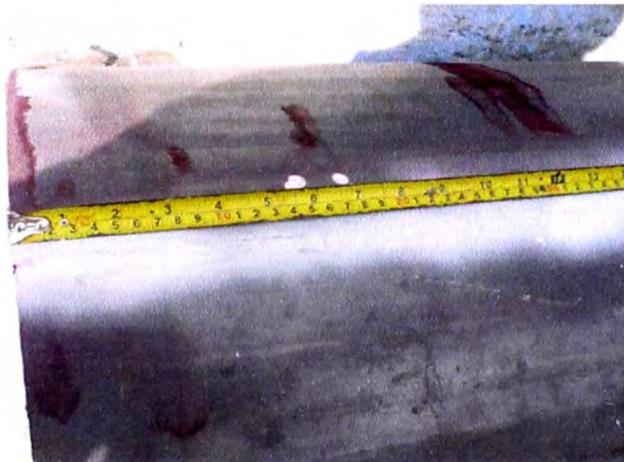
Fig. 4. 38: Cordón de soldadura sin inconvenientes. Fuente: Elaboración propia.
