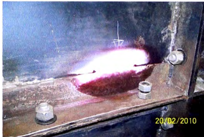
Fig. 4. 35: Cordón de soldadura sin fallas detectadas.
