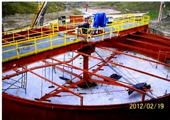
Fig. 1. 1: Tanque espesador convencional.
