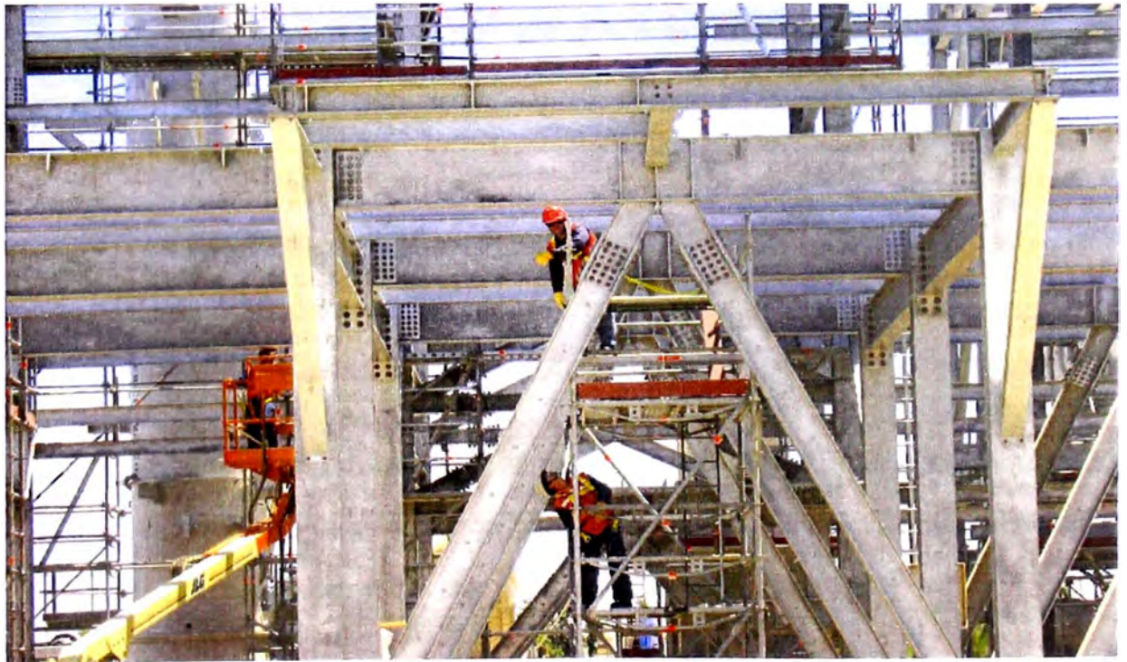
MONTAJE DE ESTRUCTURAS
