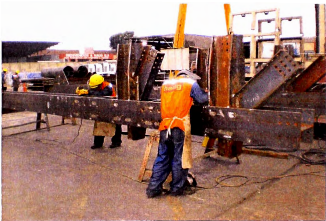
SOLDADURA DE COLUMNAS , VIGAS
