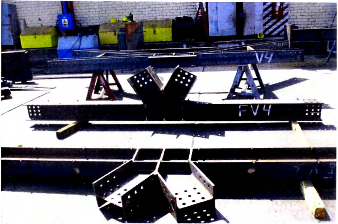
VIGAS DE AMARRE DE CON COLUMNAS
