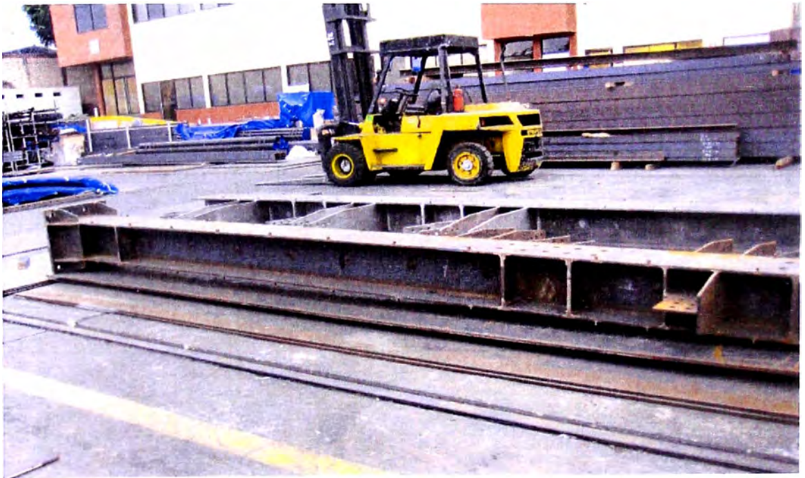
FABRICACION DE COLUMNAS
