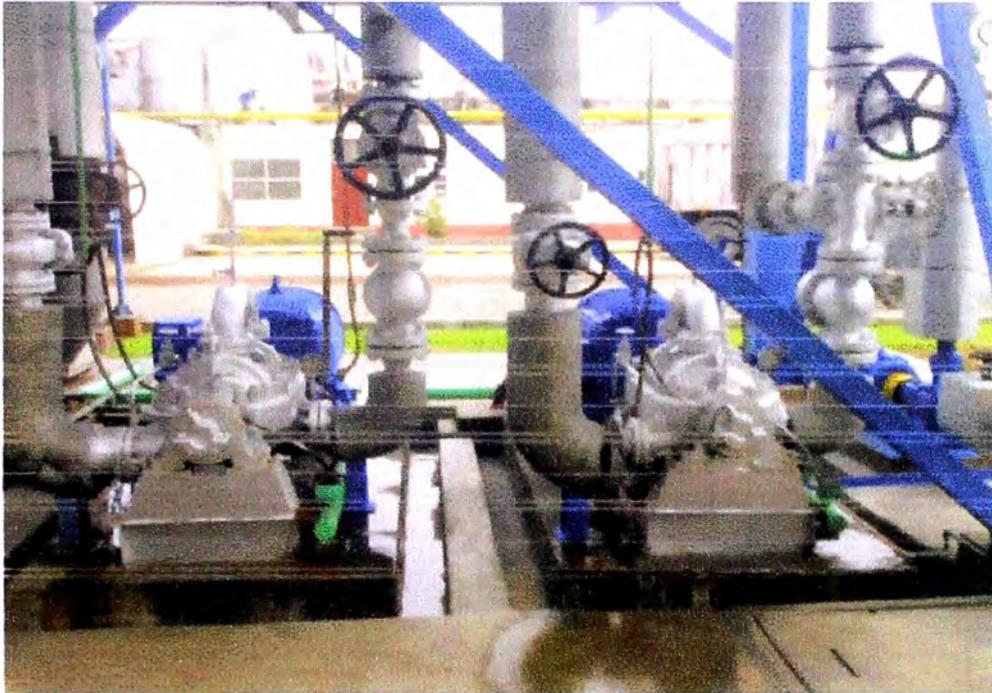
Figura 3.1. Motobombas de alimentación de agua
