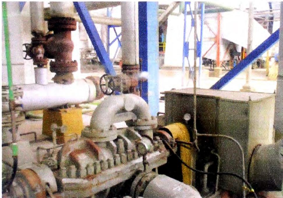
Figura 3.2. Turbobomba de alimentación de agua
