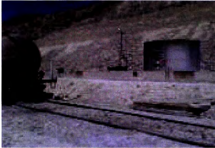
Figura 3-1: Sistema de Almacenamiento Antiguo
