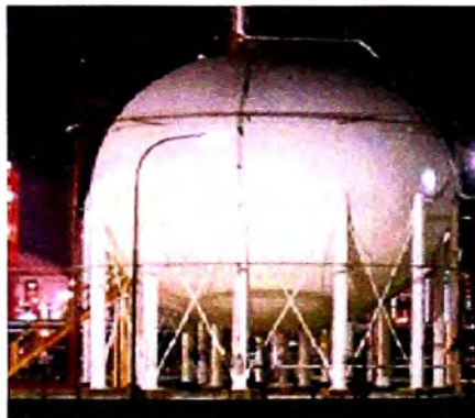
Figura 2-4: Tanque a Presión
