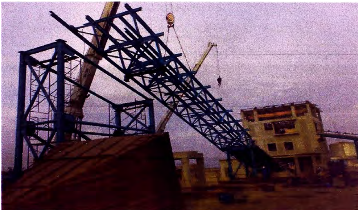
FOTOGRAFIA 5.2 OTRA VISTA REALIZANDO EL MONTAJE DEL ENREJADO VOLUMÉTRICO LA GRÚA DE 50TN SIRVE DE TIMÓN DEL MONTAJE
