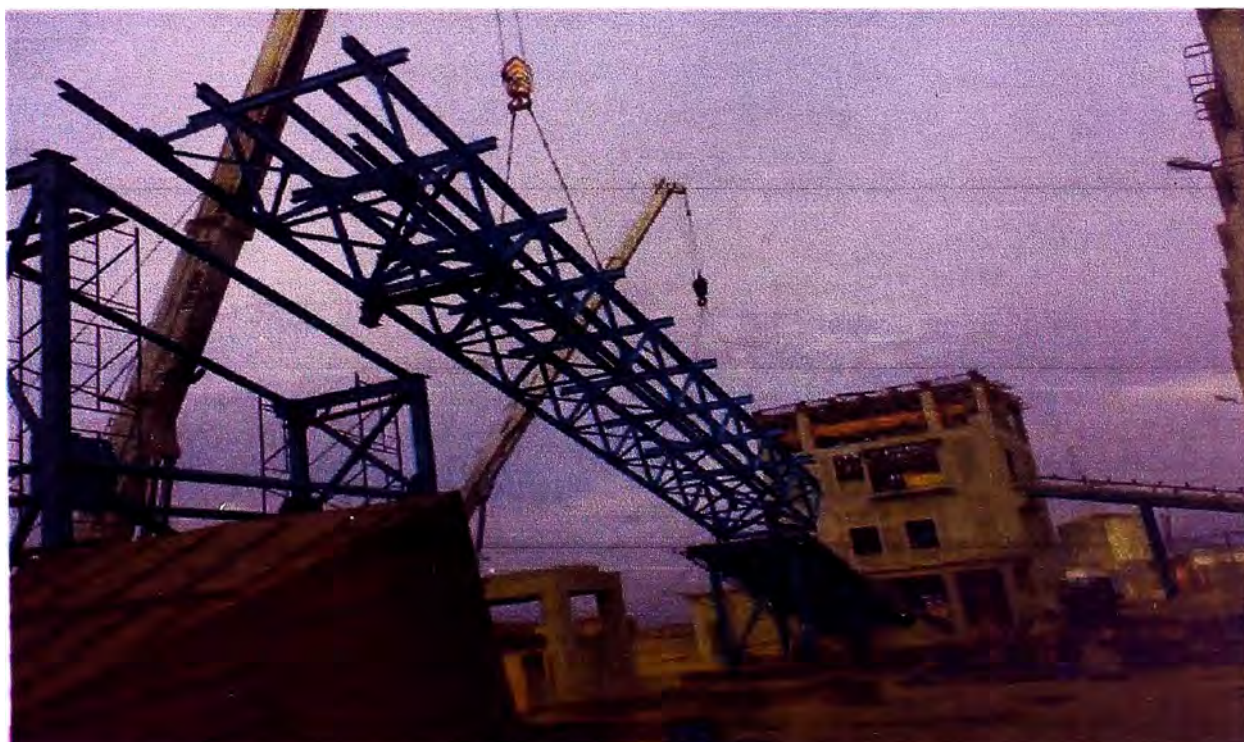
FOTOGRAFIA 5.2 MONTAJE DEL ENREJADO VOLUMÉTRICO CON 02 GRUAS DE 200TN Y DE 50TN
