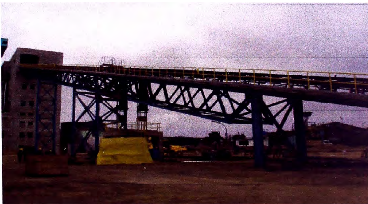
FOTOGRAFIA 5.4 SE APRECIA LA INSTALACIÓN DE LAS BARANDAS A TODO LO LARGO DE LAS FAJAS TRANSPORTADORAS
