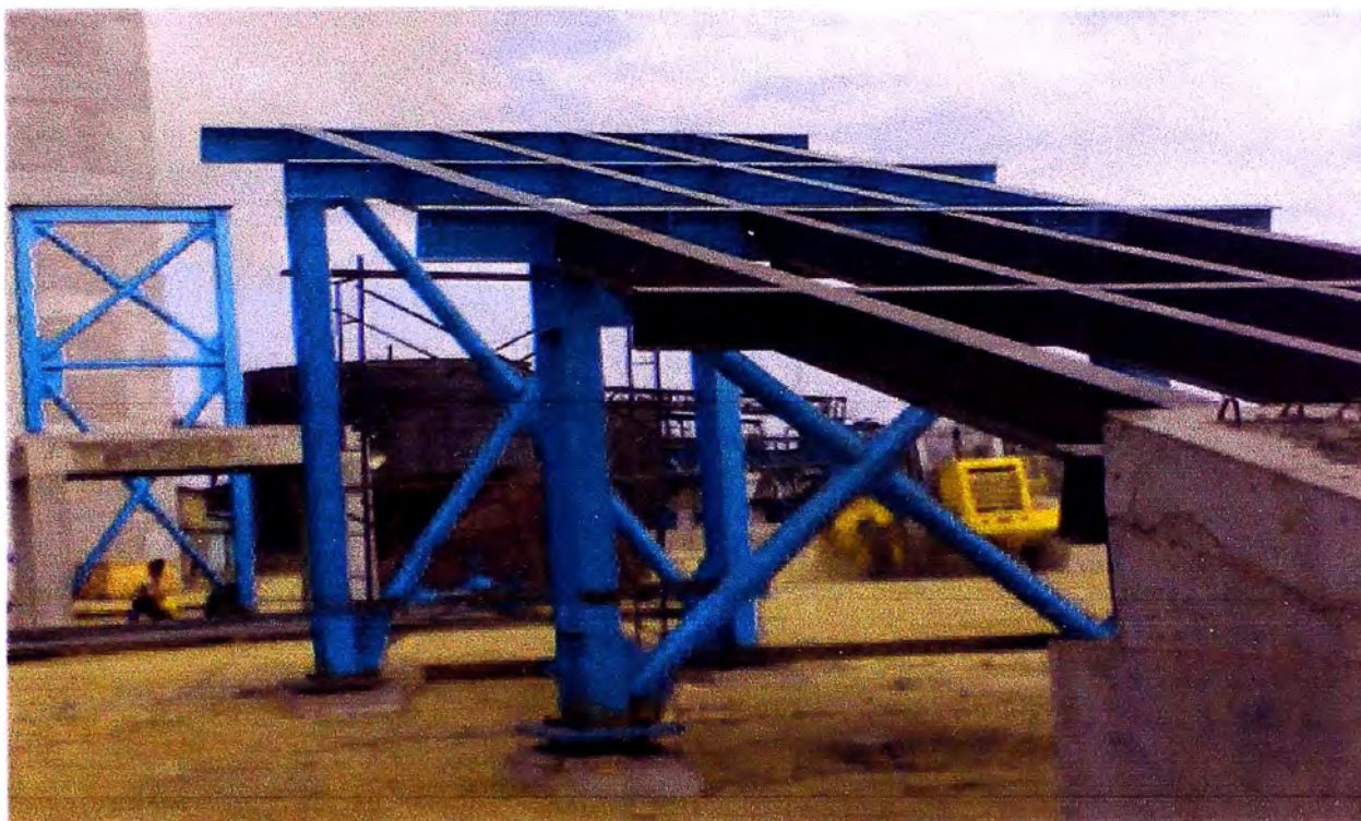
FOTOGRAFIA 5.1 SE OBSERVAN 03 PÓRTICOS YA INSTALADOS Y 02 CAMAS YA ASEGURADAS
