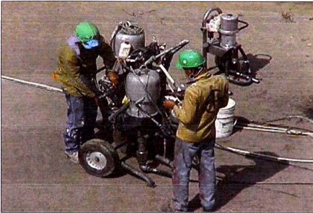
Fig. 4.22 Verificación de operatividad de equipo de aplicación
