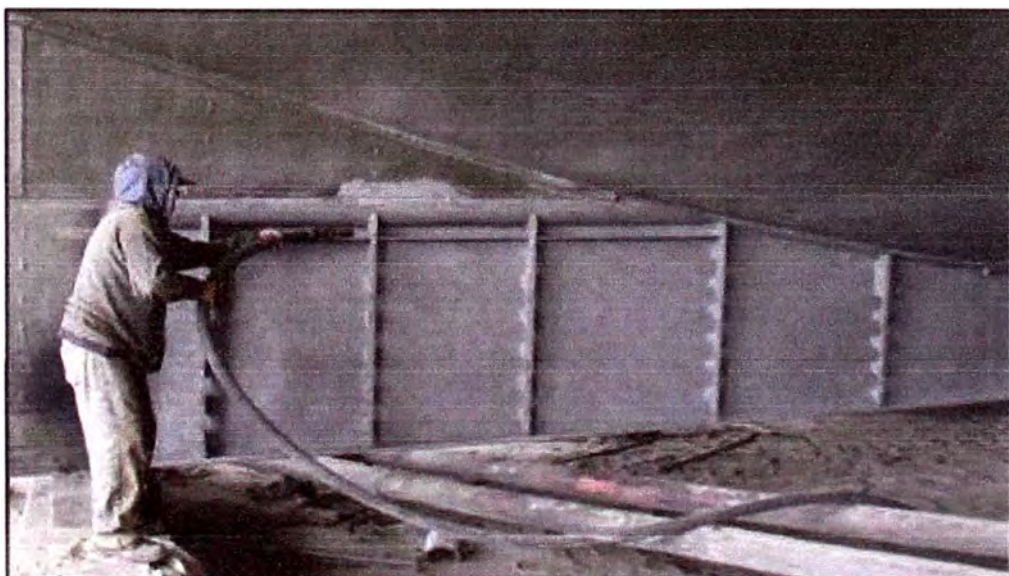
Fig. 4.1 Preparación de Superficie con chorro abrasivo (arenado)
