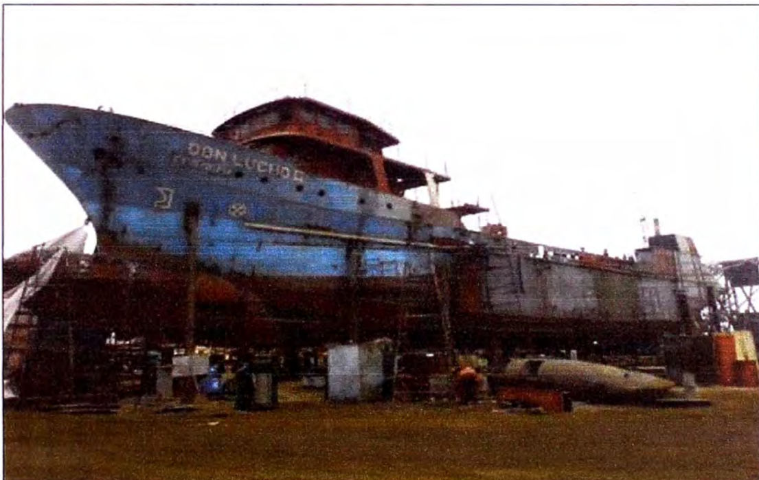
Fig. .2.1 Vista de embarcación en trabajos de mantenimiento
