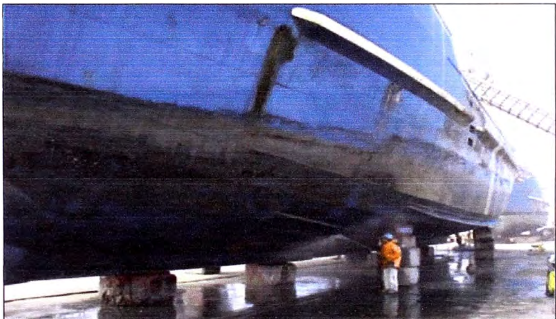
Fig. 4.3 Hidrolavado de la embarcación previo a la preparación de superficie
