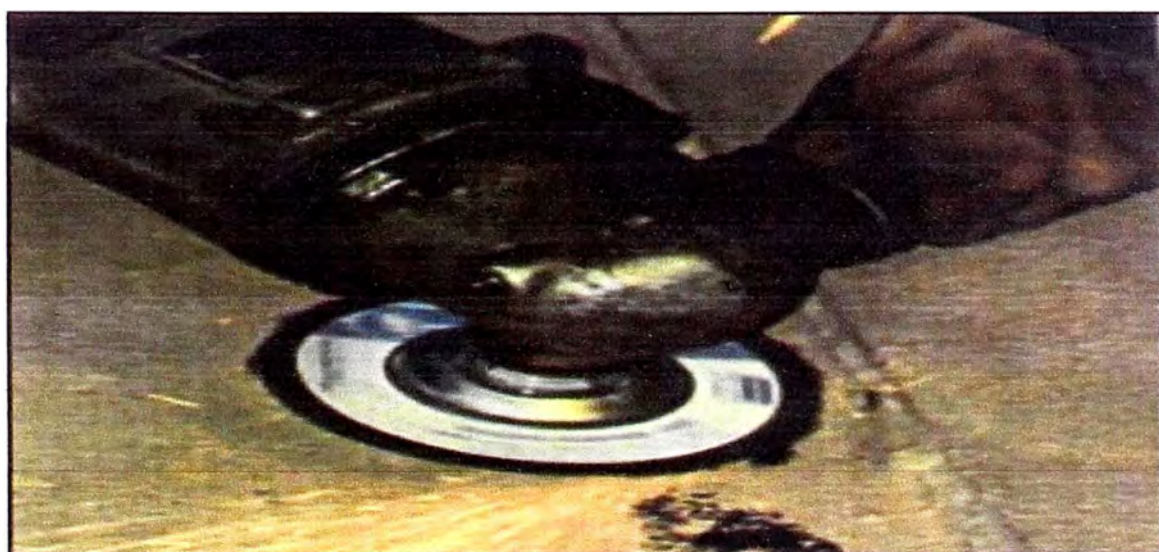
Fig. 4.2 Limpieza de cordones de soldadura y bordes filosos
