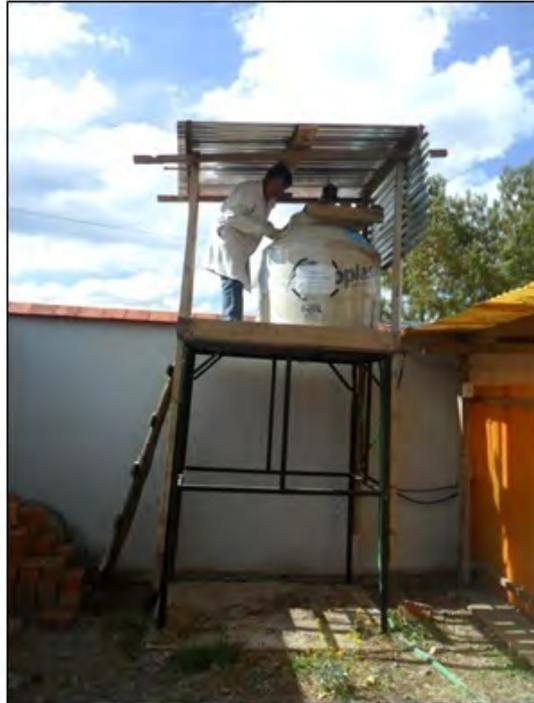
**Fotografía N° 11.3: Limpieza del tanque de almacenamiento.**
