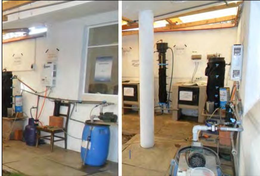
**Fotografía N° 5.7: Sistema de calentamiento vista de frente (izquierda), reactor UASB-Digester y sistema de calentamiento (derecha)**
