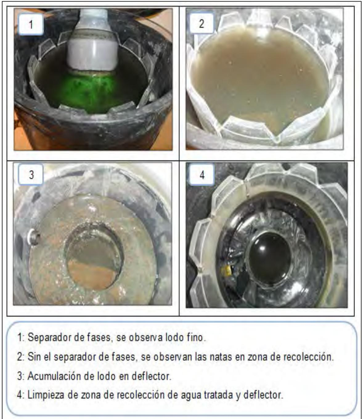
**Fotografía N° 7.1: Limpieza de vertederos, deflector y separador de fases**
