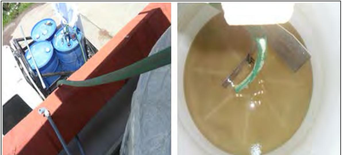
**Fotografía N° 5.6: Bombeo de agua residual al tanque de 600L (Izquierda); Mezclador en el tanque de 600L (Derecha)**
