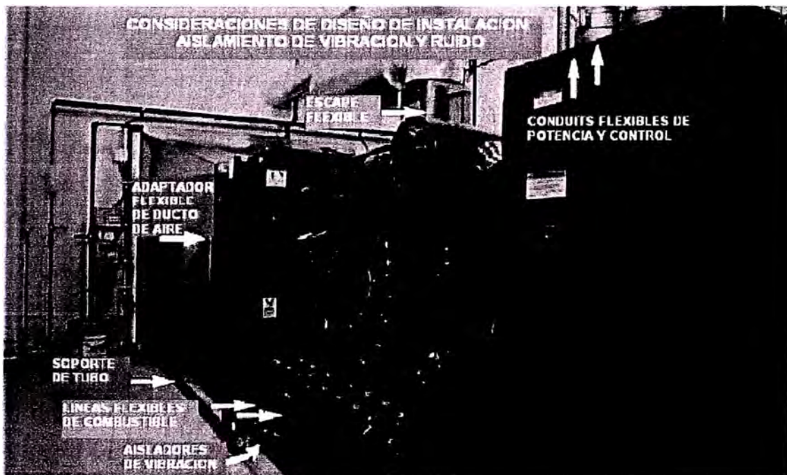
Figura 3.12 Consideraciones Antivibratorios para un Generador Típico.
