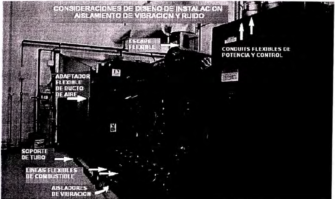
Figura 3.16 Reducción de Ruidos Transmitidos por la Estructura.
