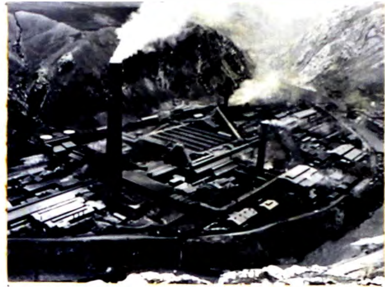
En la fundición y refinerías donde hay que conocer los riesgos de los múltiples procesos y operaciones.
