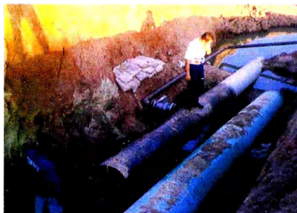
b) Cabezal soldado a tramo de ducto para iniciar prueba hidrostática.
