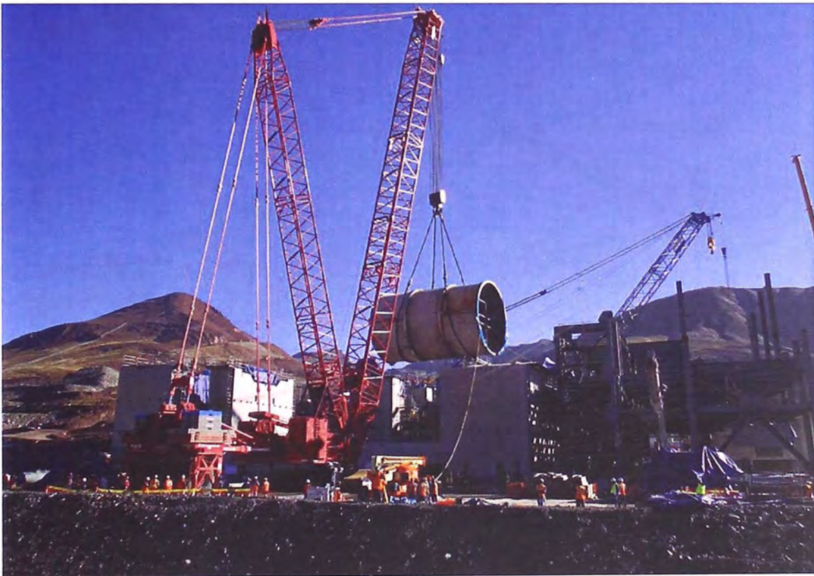
Foto 5.17.- Izaje de cilindro o Shell de molino de bolas, sobre su base de concreto.
