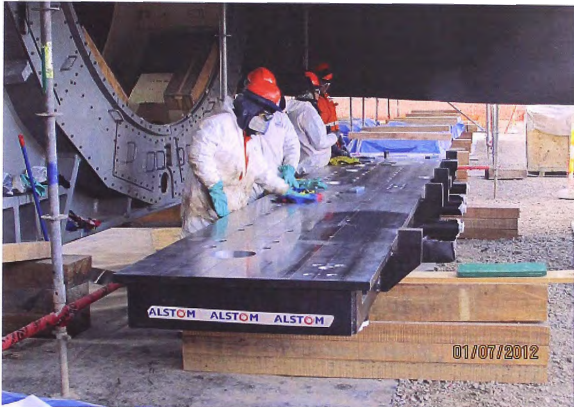
Foto 5.10.- Limpieza mecánica de sole plate.
