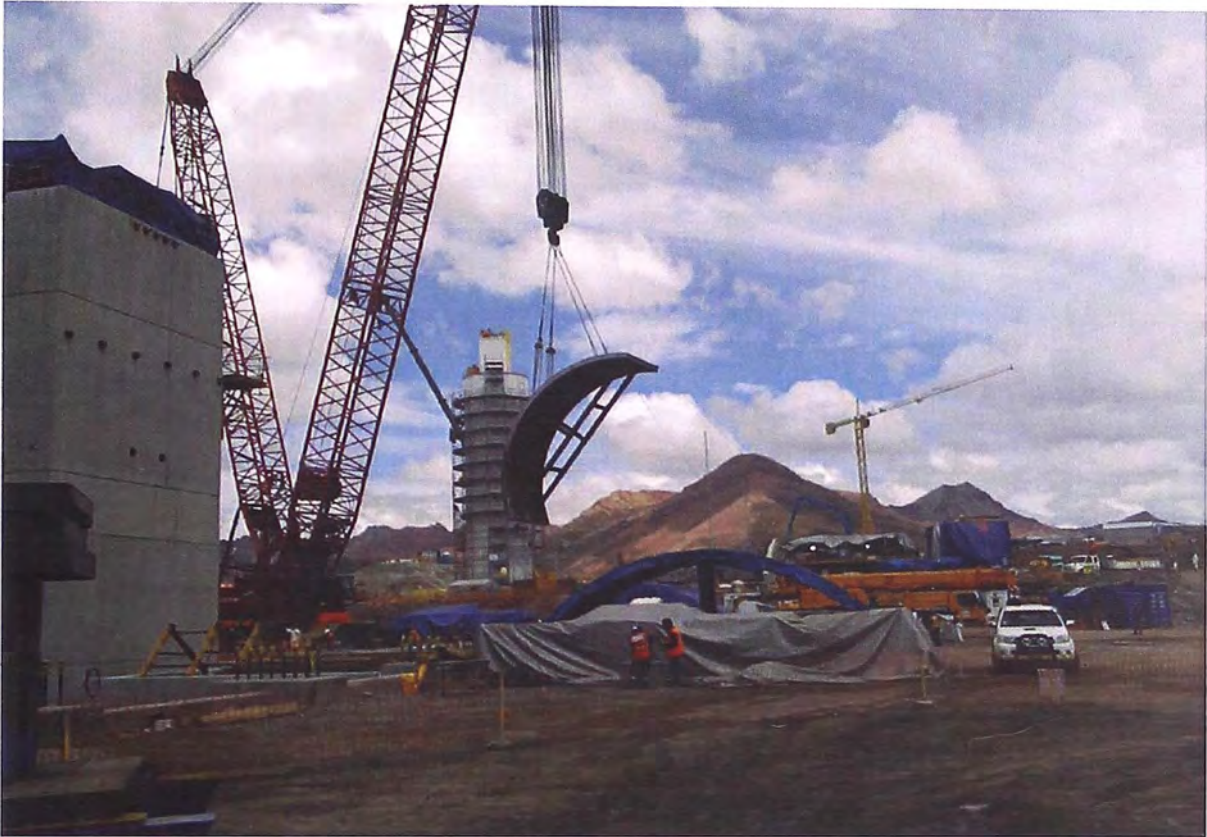
Foto 5.26.- Izaje de una sección del molino Sag.
