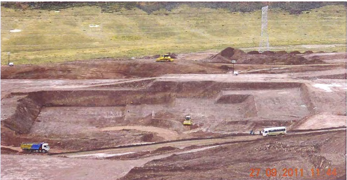
Foto 5.2.- Excavación para bases de molinos Bolas y Sag.
