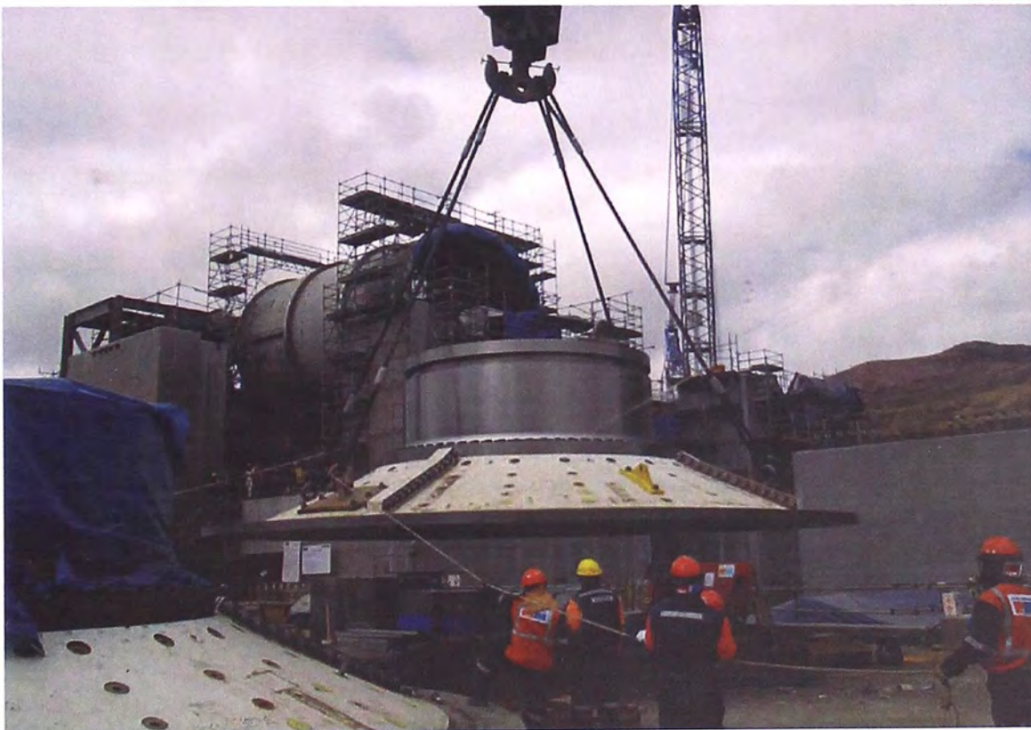
Foto 5.20.- Izaje de tapas de molino sobre el Shell.
