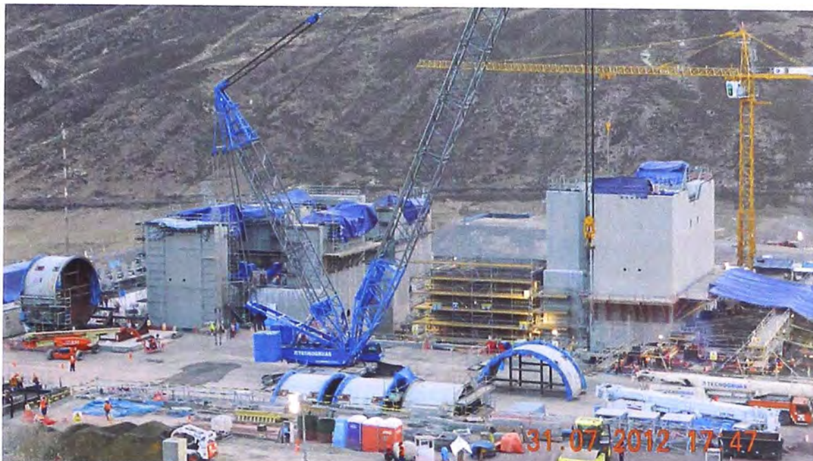
Foto 5.5.- Se muestra pre armado de cilindro molino de bolas.
