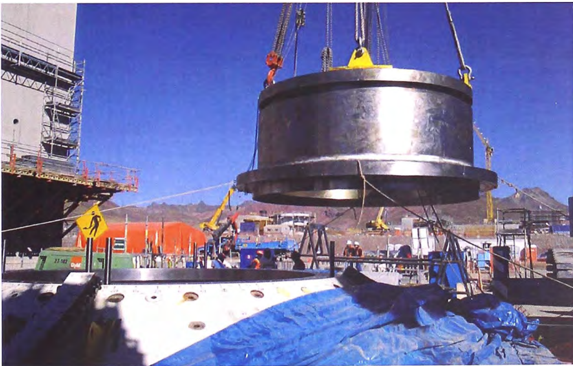
Foto 5.19.- Montaje de trunnion en tapa de molino de bolas, en piso.
