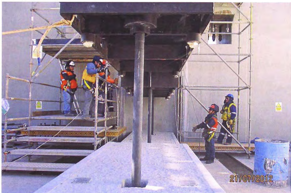
Foto 5.11.- Montaje de sole plates bajo motor eléctrico.
