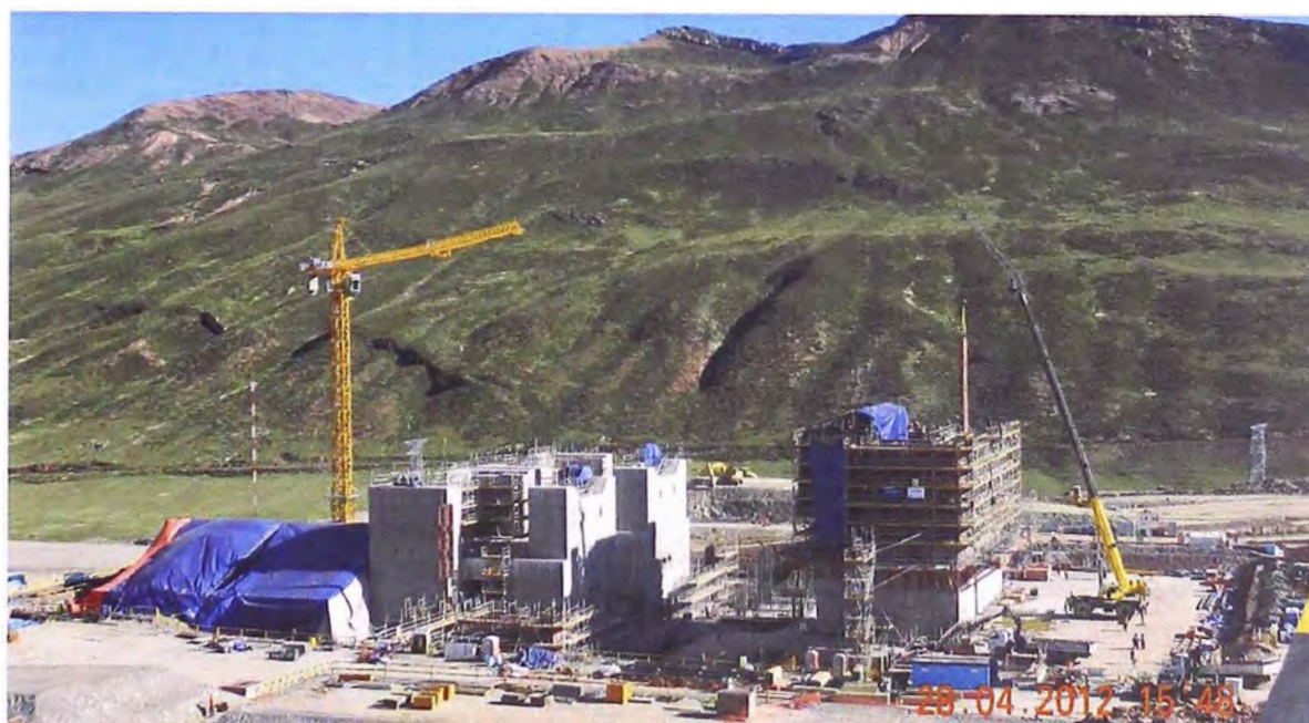
Foto 5.3.- Inicio de la construcción, bases de concreto para los molinos.
