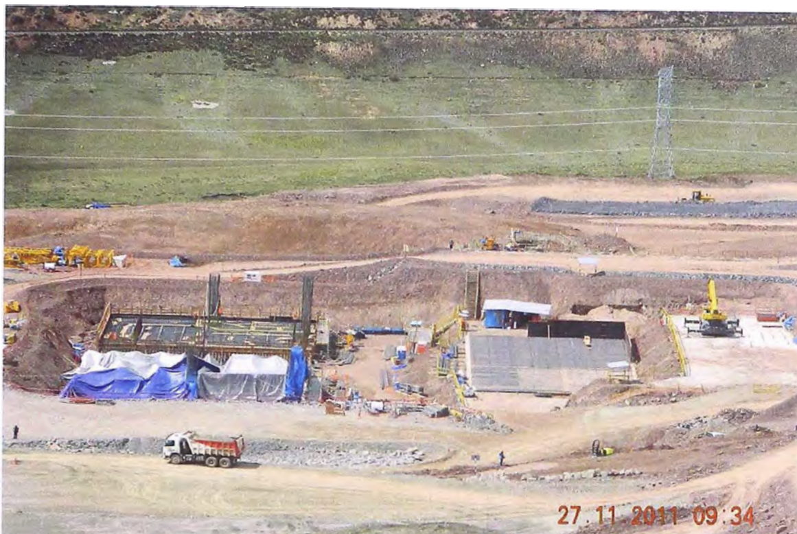
Foto 5.3.- Inicio de la construcción, bases de concreto para los molinos.
