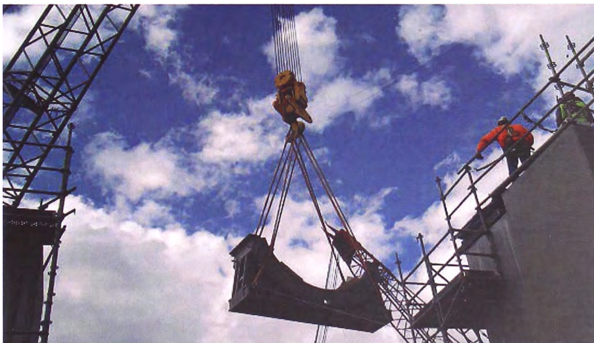
Foto 5.9.- Izaje de base o descanso inferior de chumacera de molino.
