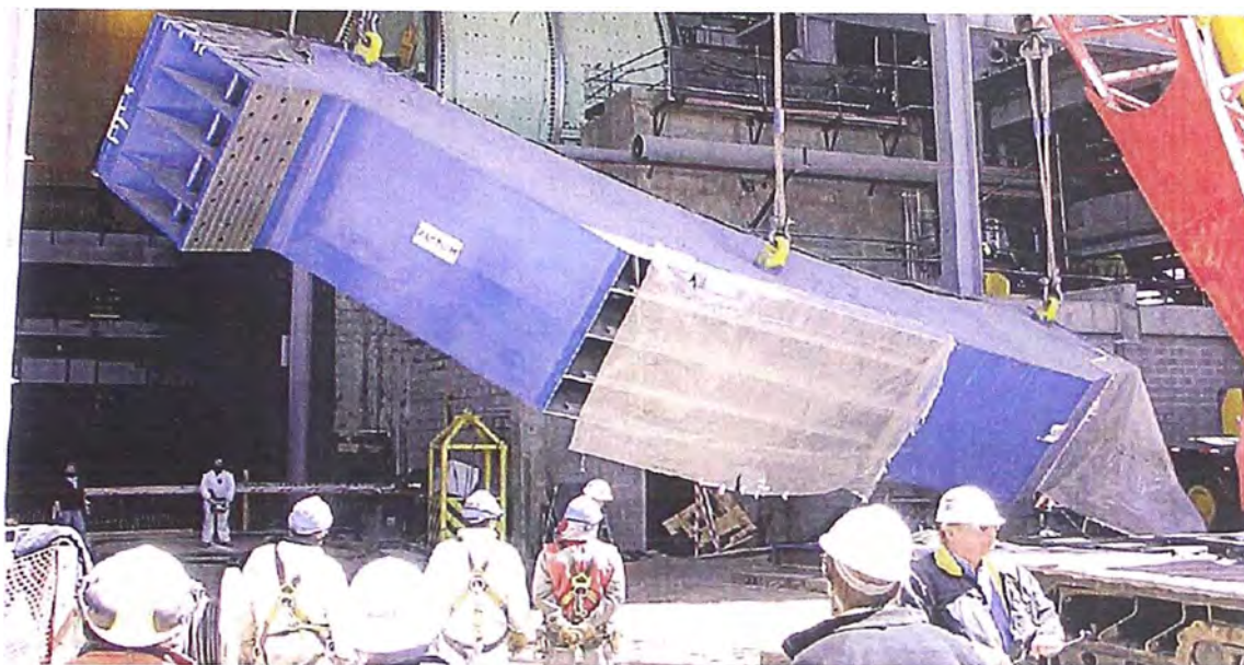
Foto 5.34.- Volteo de parte de estator.
