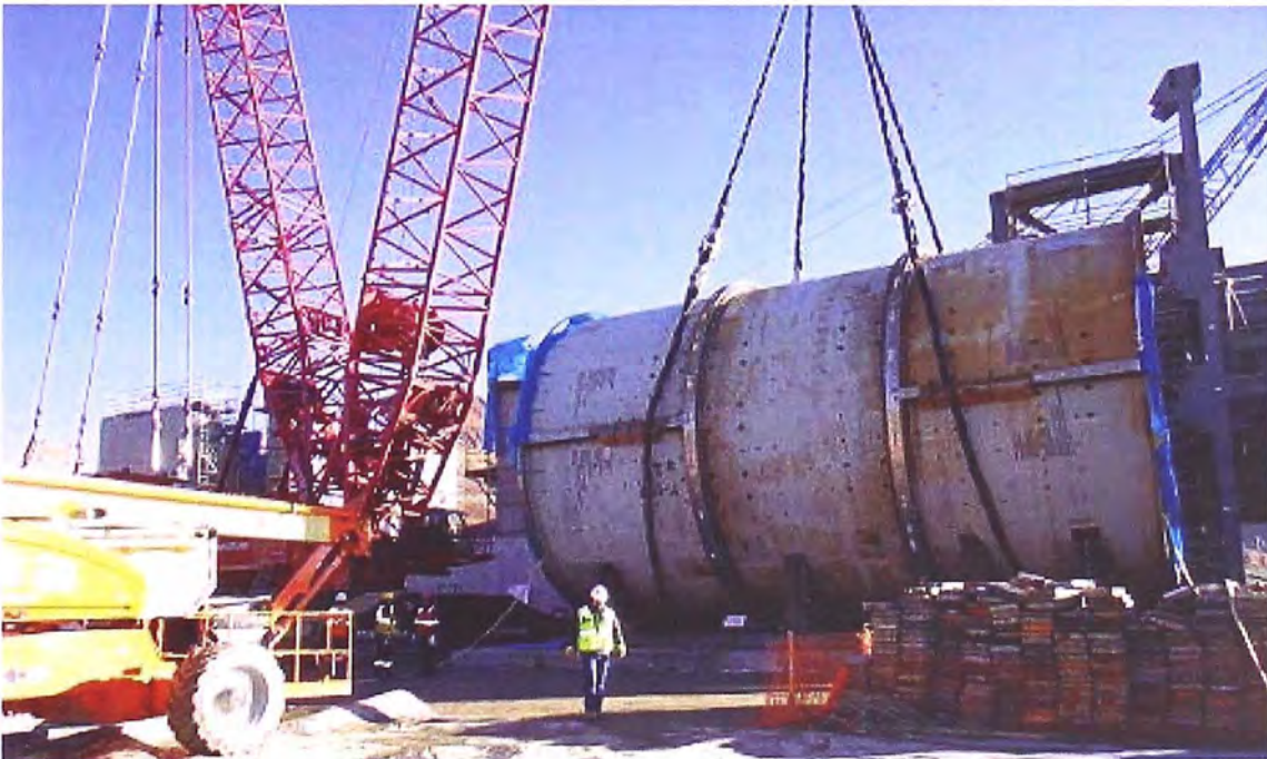
Foto 5.15.- Izaje del cilindro, molino de bolas ensamblado en el piso. Peso 377.9 ton.
