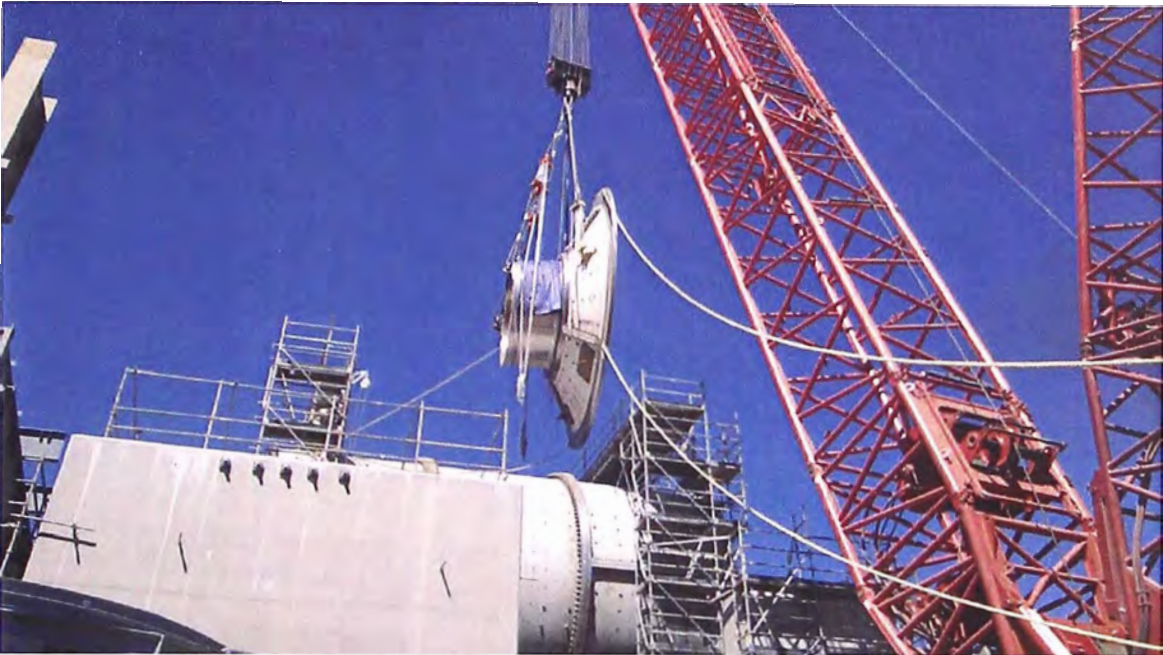
Foto 5.21.- Izaje de tapas de molino sobre el Shell.
