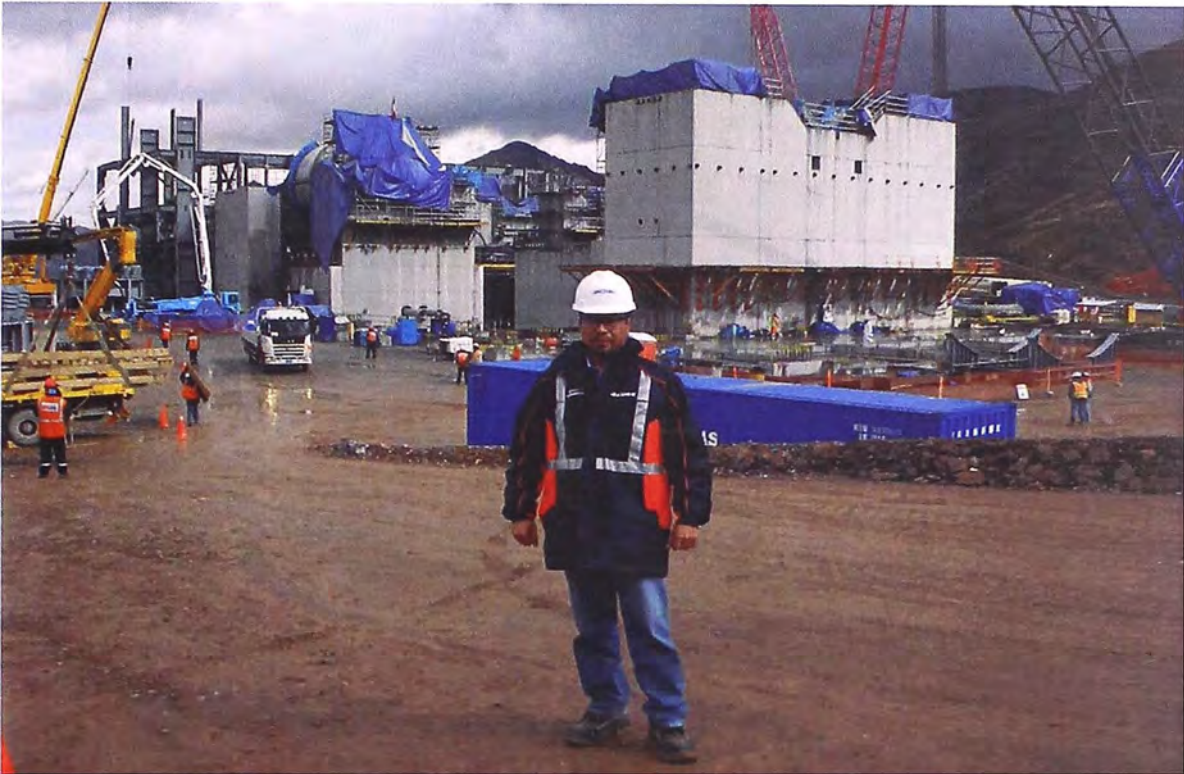
Foto 4.4.- Bases de concreto para molinos en proceso de construcción.
