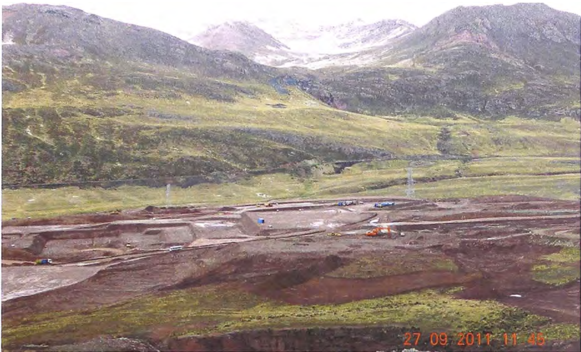
Foto 5.1.- Movimiento de tierras edificio de molienda.
