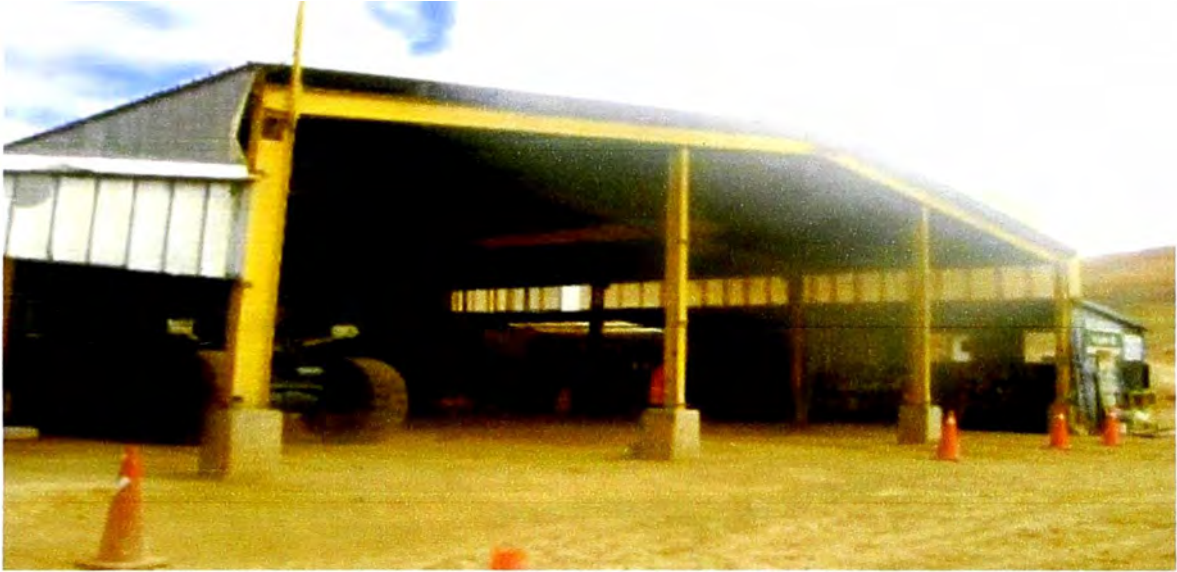
Fotografía N°3.1 Vista frontal de taller
