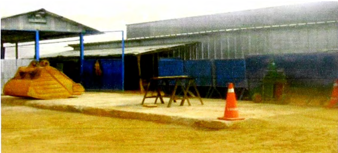
Fotografía N° 3.4 Nuevo taller de soldadura
