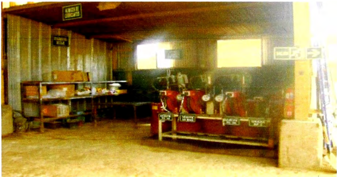
Fotografía N° 3.2 Área de lubricación
