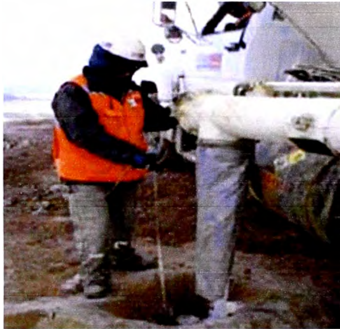
Fotografía N° 1.2 Proceso de carguío de explosivos en los bancos
