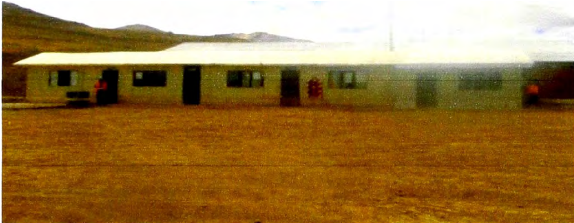
Fotografía N°3. Oficinas y comedor de mantenimiento
