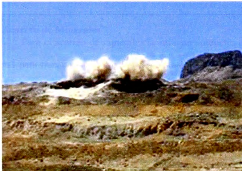
Fotografía N° 1.3 Proceso de voladura de los bancos
