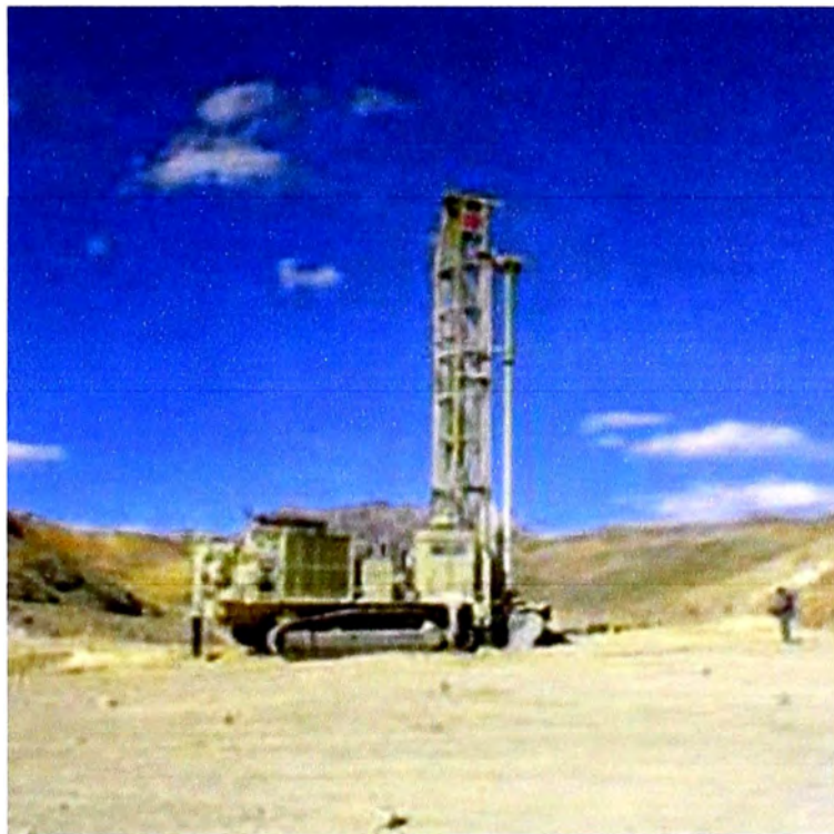
Fotografía N°1.1 Proceso de perforación de los bancos.
