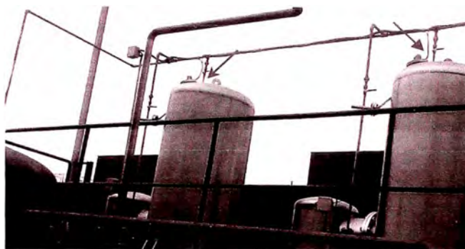
Figura N° 4.33 – Línea de limpieza de sensores de nivel
