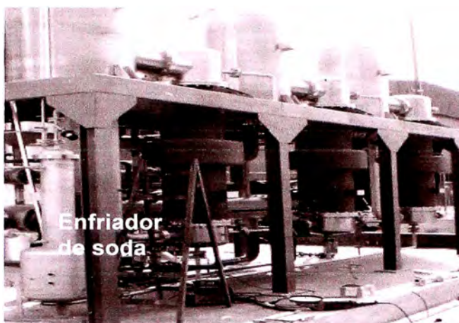
Figura N° 4.18 – Montaje de la sección de evaporación sobre estructura
