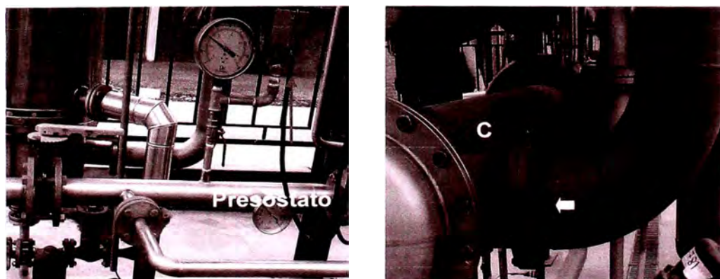
Figura N° 4.32 – Línea de agua blanda para condensador
