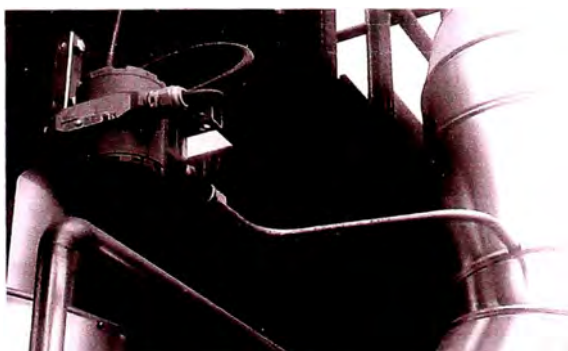
Figura N° 4.22 – Transmisor de presión en línea
