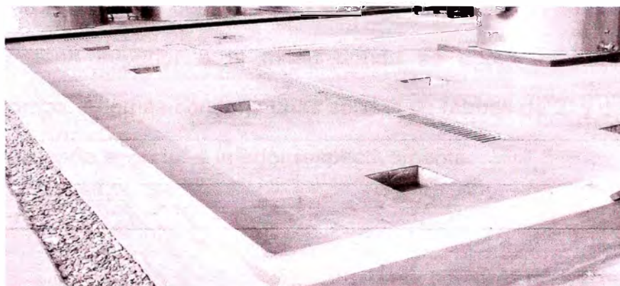
Figura N° 4.3 – Losa de concreto terminada
