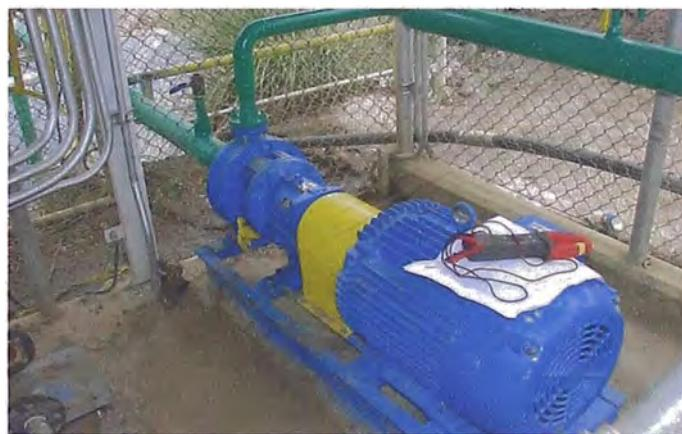
**Figura 3.4 Bomba centrífuga montada en el km 31**
