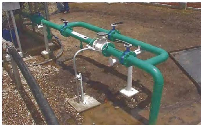
**Figura 3.6 Spool de tubería de acero montada en el km 31**
