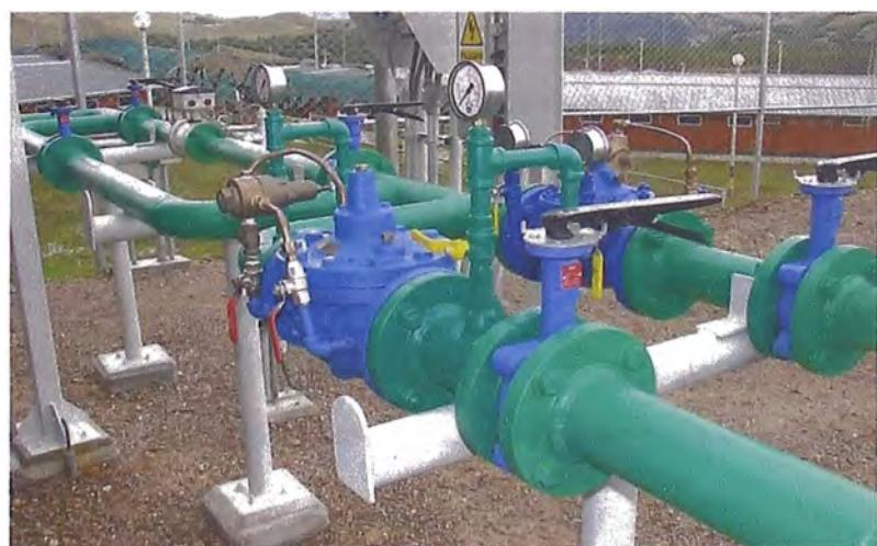
**Figura 3.7 Spool de tubería de acero montada en el km 37**
