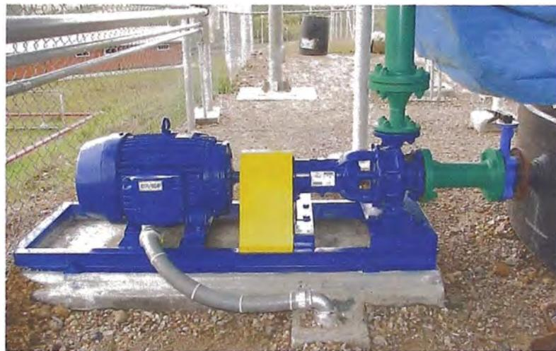
**Figura 3.5 Bomba centrífuga montada en el km 37**
