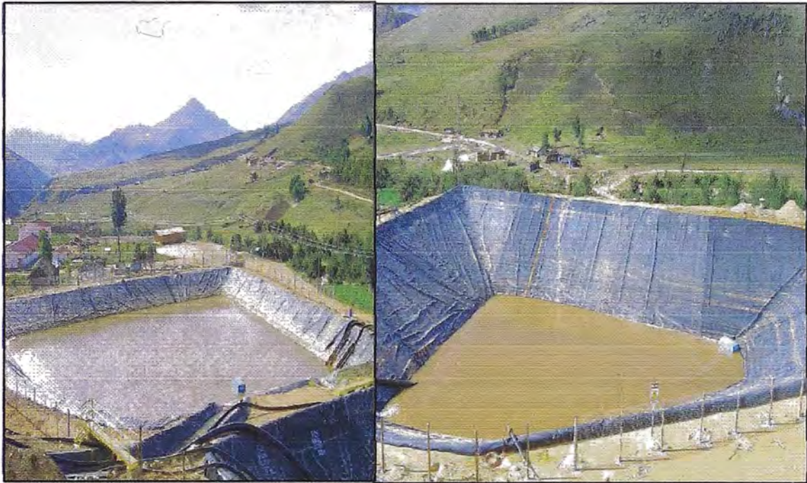
Figura III.8 Pozas Barren y Pregnant (izquierda y derecha respectivamente).
